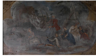
Détail de la toile marouflée, très abîmée, ornant le dessus-de- porte occidental de la pièce est. Phot. Stéphane Asseline IVR11_20097701696NUC4A
