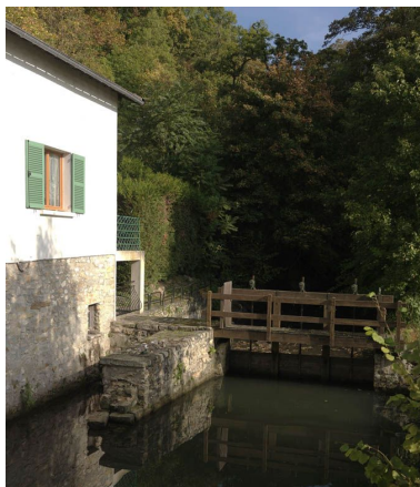
Façade orientale du moulin, emplacement de la roue et vanne. Phot. Philippe Ayrault IVR11_20097701529NUC4A
