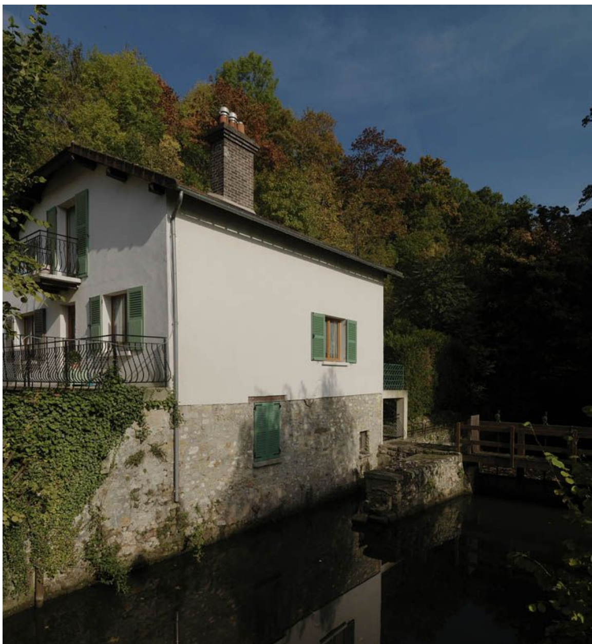
Le moulin bordant le ru du Châtelet.
