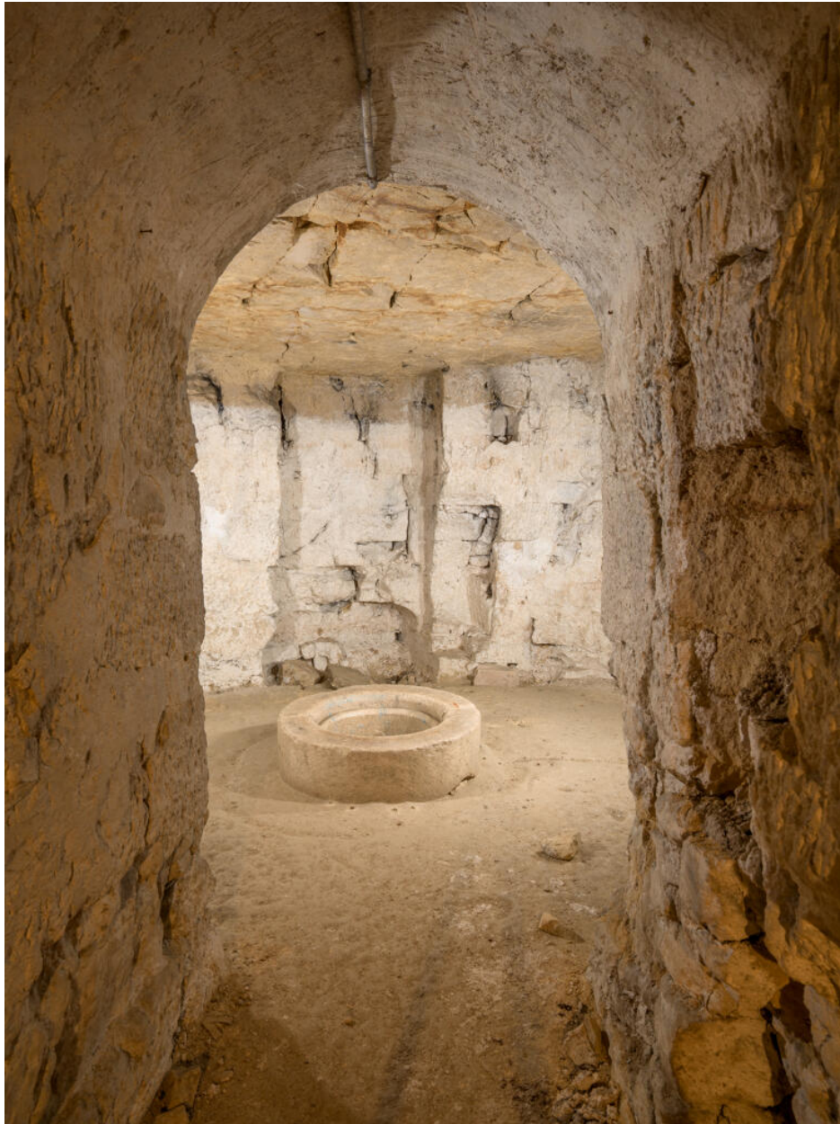
Oculus d'un silo de 60 m 3 , vestige des grands projets de greniers à blés pour l'alimentation des parisiens entre 1800 et 1850. L'emplacement d'un treuil est visible (au fond).
