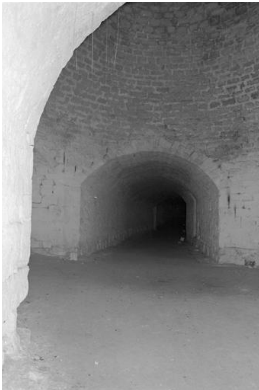
Carrefour de quatre galeries. Au fond, l'une des galeries.
