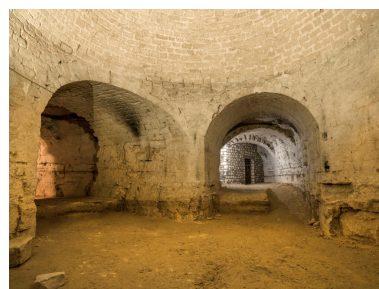
Sol de la coupole maçonnée et galerie d'accès originelle (gauche). La stratigraphie des remblai (au fond) donne les différents niveaux d'occupation : passage charretable, champignonnière, occupation allemande, puis de nouveau champignonnière. Phot. Asseline Stéphane IVR11_20249400051NUC4A
