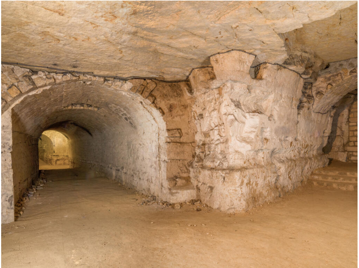
Galerie de circulation charrettable percée par la société des Caves d'Ivry c.1820.
