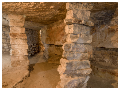
Piliers à bras et front de taille. Masse en partie souchevée. Phot. Asseline Stéphane IVR11_20249400046NUC4A
