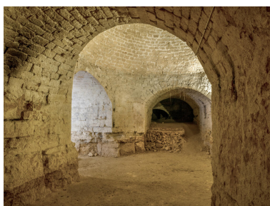
Vue de la coupole depuis la galerie d'accès originelle. Le sol a été décaissé postérieurement. Phot. Asseline Stéphane IVR11_20249400050NUC4A
