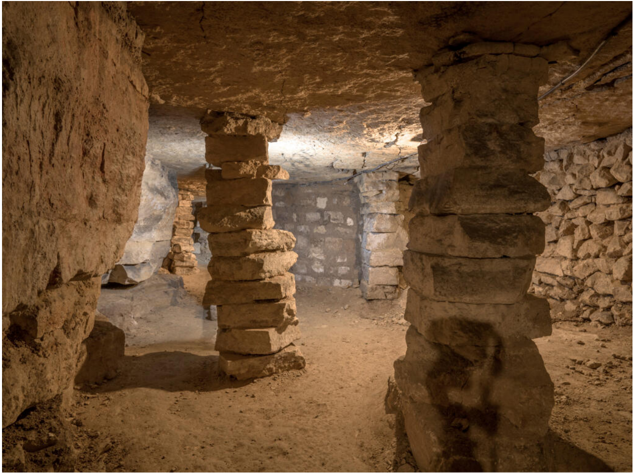
Front de taille (gauche) et piliers à bras. Hagues et bourrage (droite) et consolidation moderne du XXe siècle (fond).
