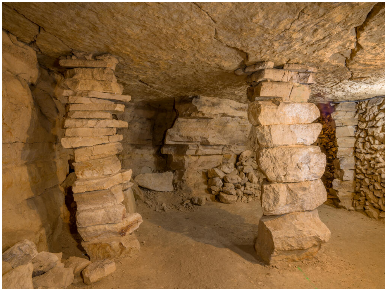
Piliers à bras et front de taille avec tranche de défermage.
