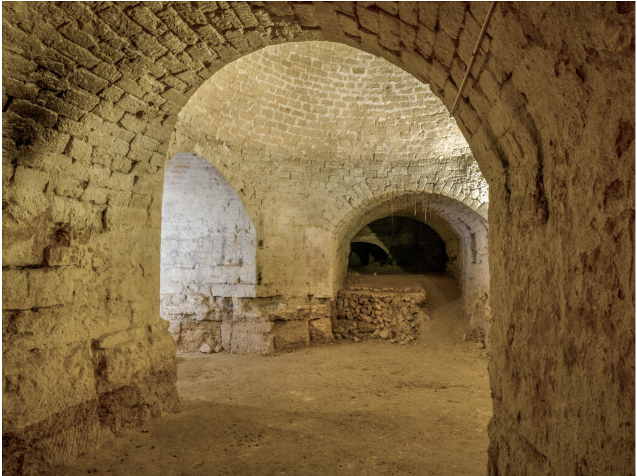
Vue de la coupole depuis la galerie d'accès originelle. Le sol a été décaissé postérieurement.
