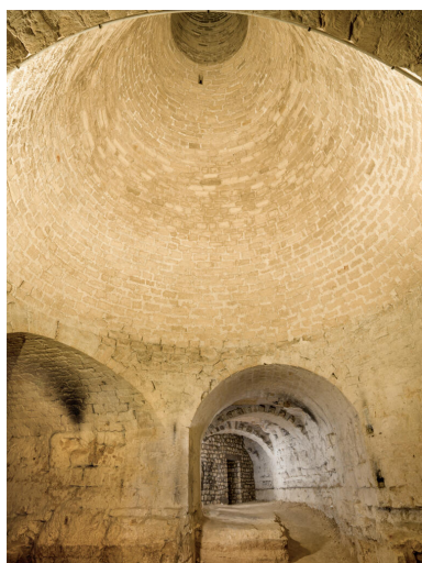
Coupole tronconique de 14 mètres à l'intersection de quatre galeries de circulation charretables, c.1820. Dénommée 'tunnel' (en raison de sa forme similaire aux tonnelles pour la chasse), elle est la pièce centrale d'un système de ventilation des caves. Phot. Asseline Stéphane IVR11_20249400049NUC4A
