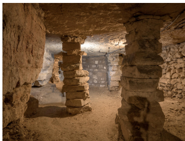
Front de taille (gauche) et piliers à bras. Hagues et bourrage (droite) et consolidation moderne du XXe siècle (fond). Phot. Asseline Stéphane IVR11_20249400047NUC4A
