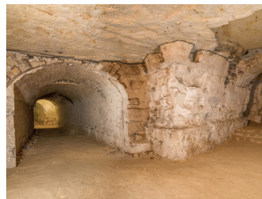
Galerie de circulation charretable percée par la société des Caves d'Ivry c.1820. Phot. Asseline Stéphane IVR11_20249400048NUC4A
