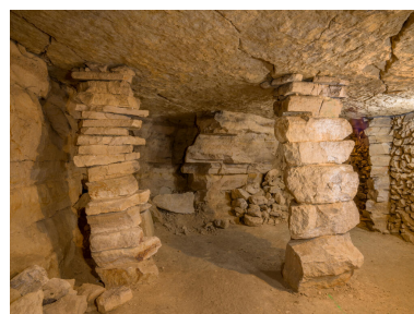
Piliers à bras et front de taille avec tranche de défermage. Phot. Asseline Stéphane IVR11_20249400045NUC4A
