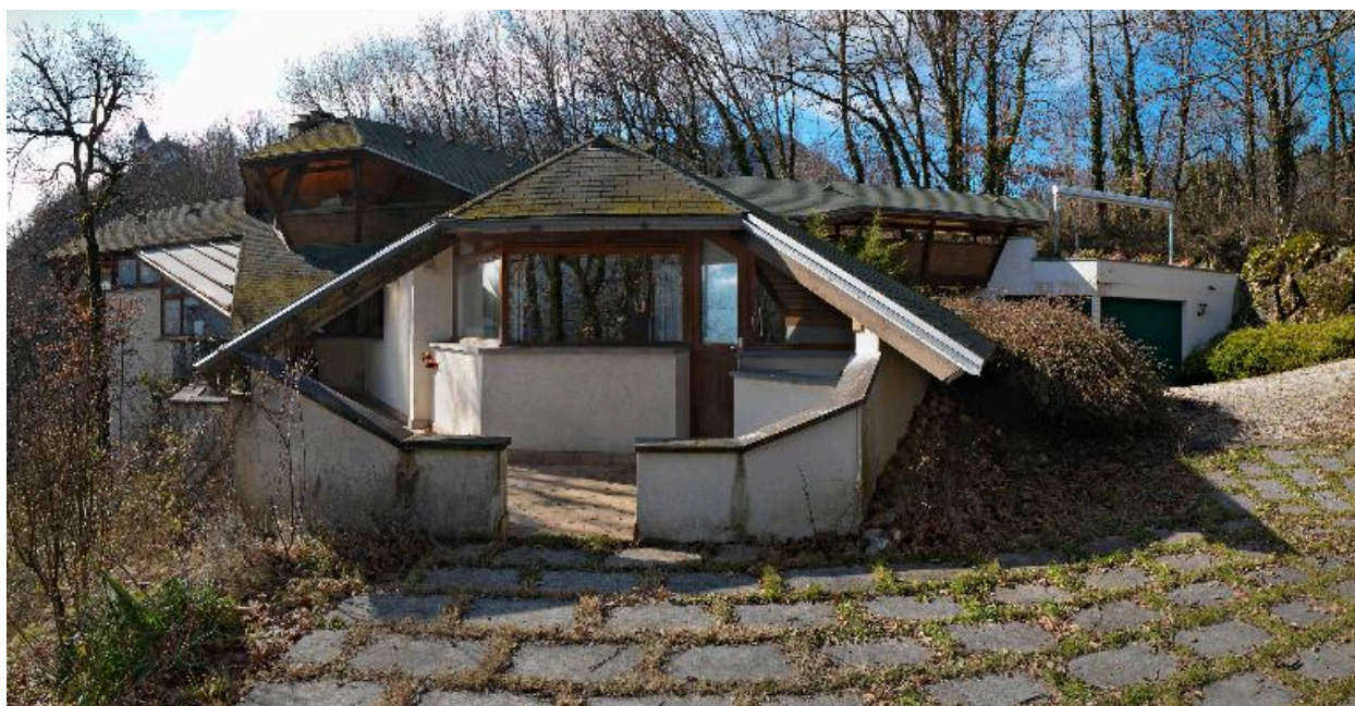
Vue de l'entrée de la maison située sur l'une des façades latérales.
