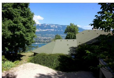
Vue rapprochée d'une partie de la toiture. Phot. Eric Jacquard IVR11_20177300019NUC4A
