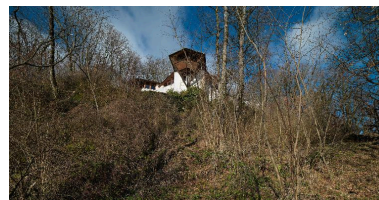
Vue prise en contrebas d'une des nacelles de la façade postérieure. Phot. Eric Dessert IVR84_20187301014NUCA
