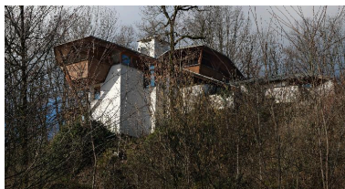
Vue de la façade postérieure (3). Phot. Eric Dessert IVR84_20187301068NUCAQ
