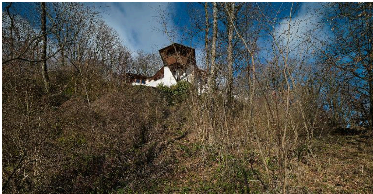
Vue prise en contrebas d'une des nacelles de la façade postérieure.
