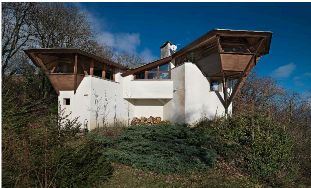
Vue rapprochée de la façade postérieure.
