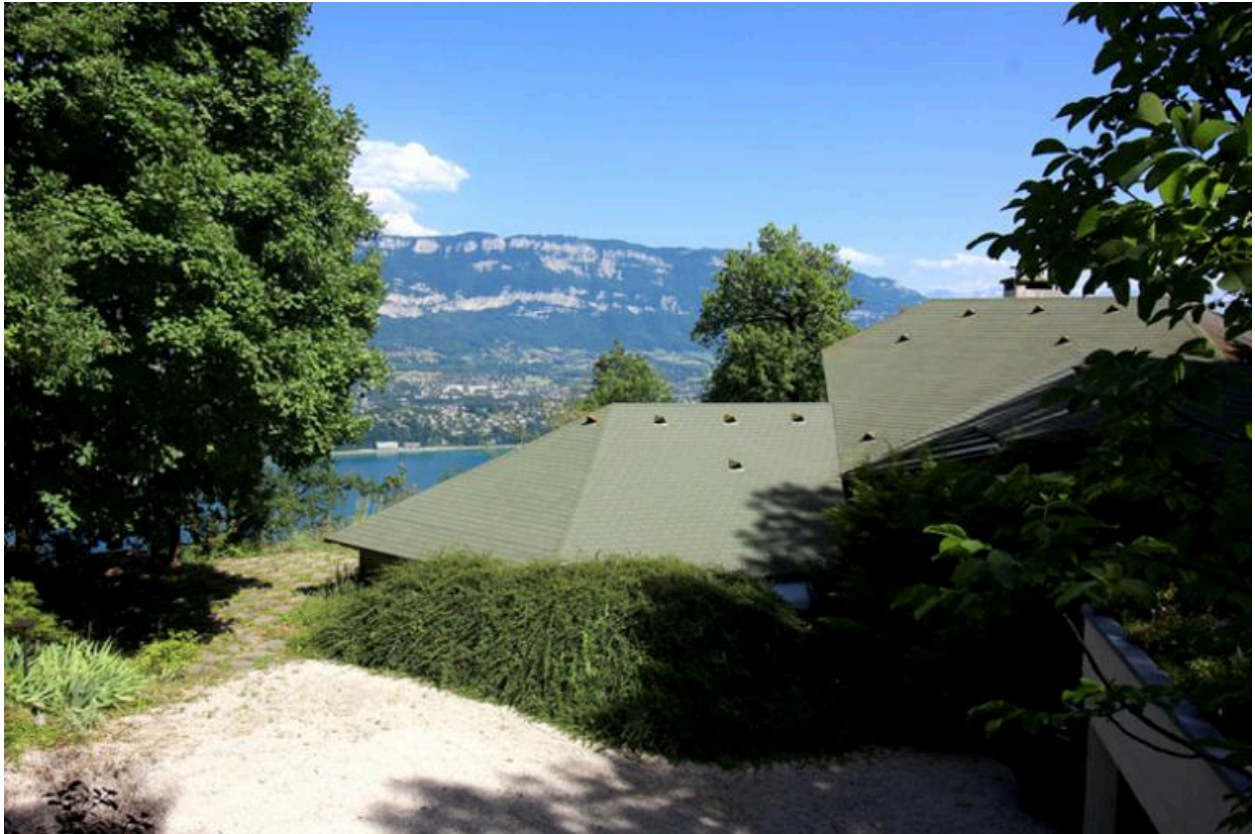
Vue rapprochée d'une partie de la toiture.
