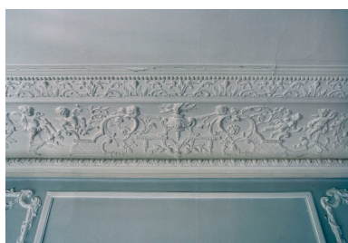
Grand salon : détail de la frise ornée de putti jouant. Phot. Jean-Bernard Vialles IVR11_20069500193XE
