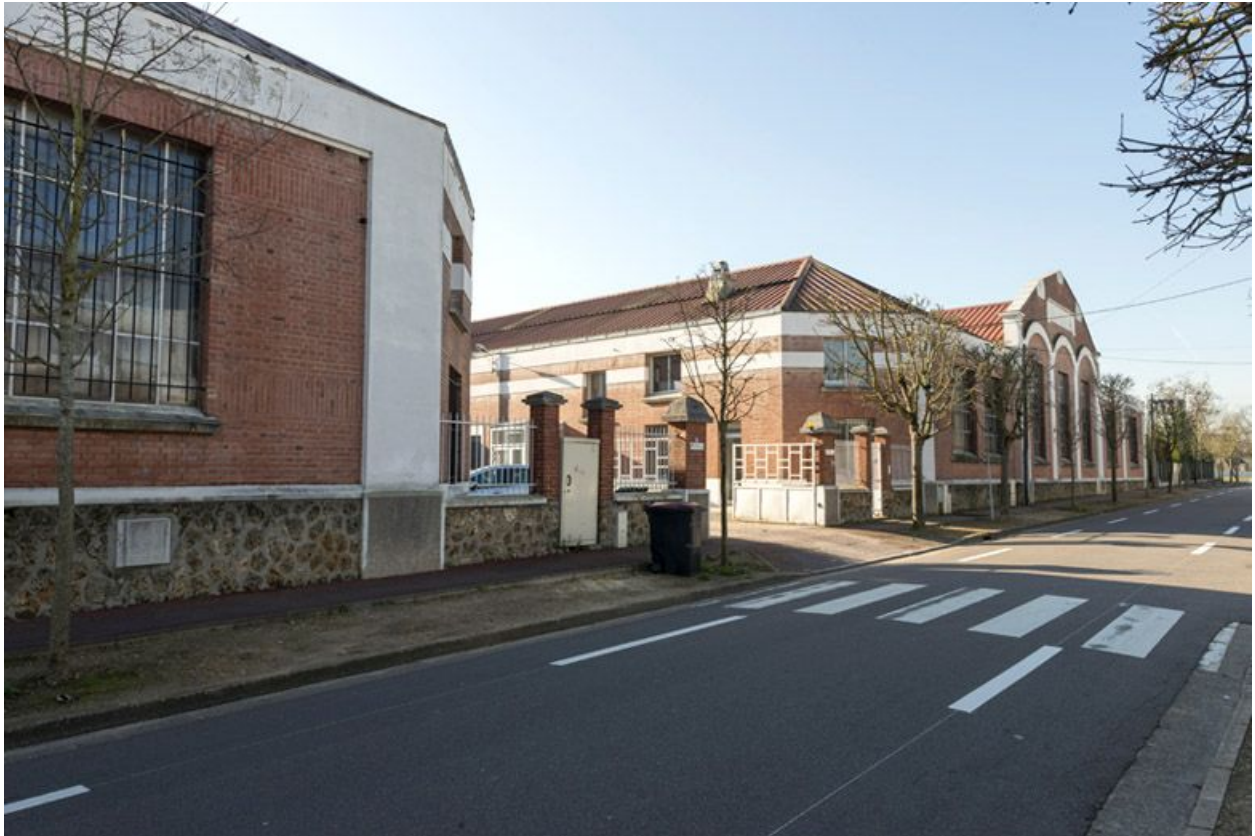
Usine, Mantes (boulevard de ) 20. Vue latérale de l'usine.
