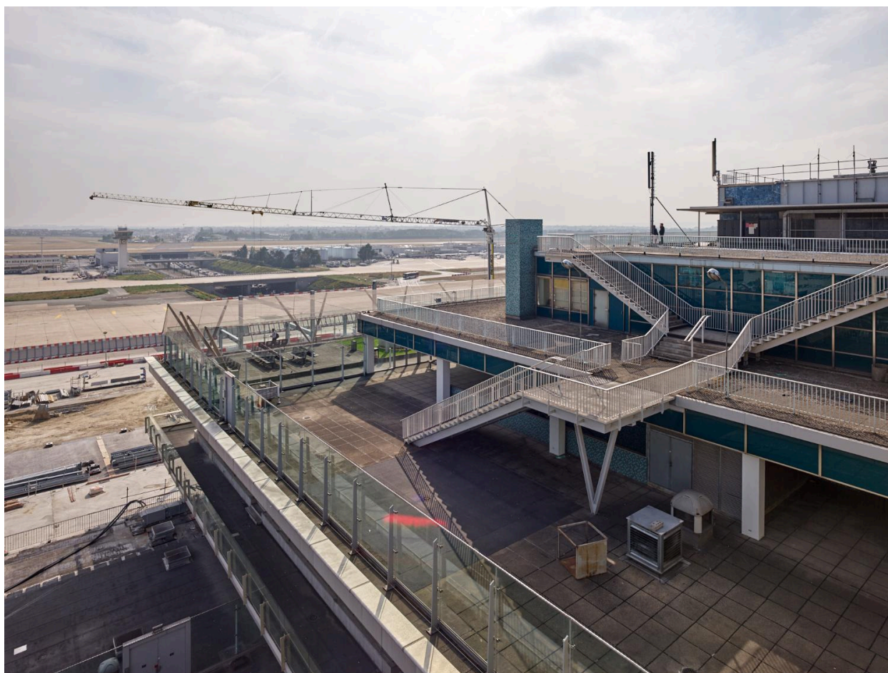
2018, terrasses, circulation verticale: escaliers est, 6ème étage.
