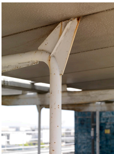
2018, auvent dessiné par Jean Prouvé, gousset portant un bac en aluminium, 6ème étage.
