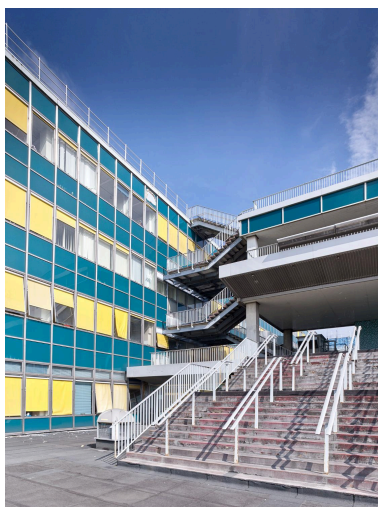
2018, terrasses, circulation verticale: escalier ouest, 4ème étage. Phot. Stéphane Asseline IVR11_20209400312NUC6A
