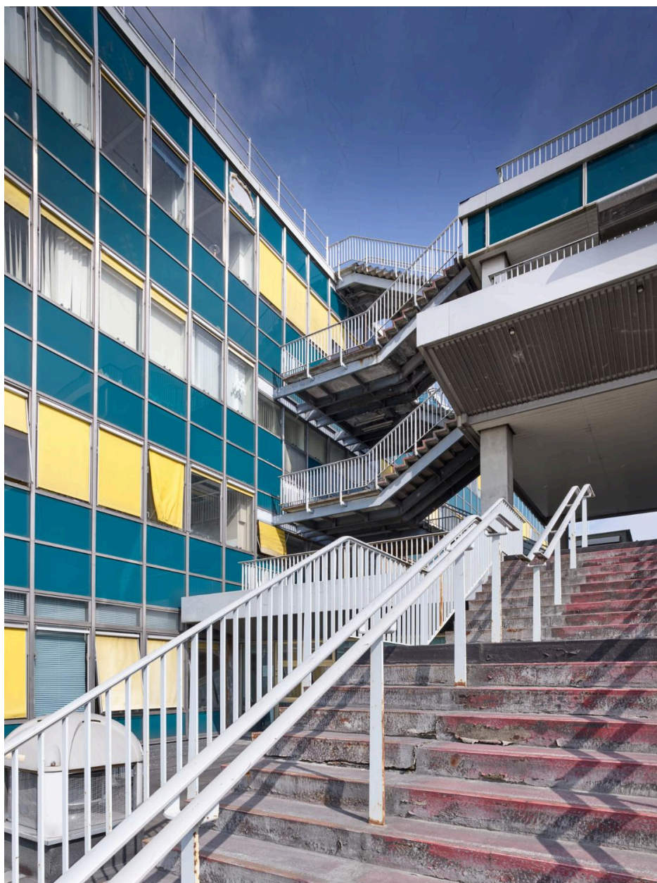
2018, terrasses, circulation verticale: escalier ouest, 4ème étage.
