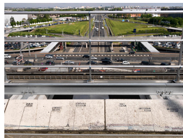
2018, table d'orientation coté nord, 6ème étage. Phot. Stéphane Asseline IVR11_20209400147NUC4A
