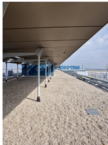
2018, auvent dessiné par Jean Prouvé, la charpente des portiques en tube d'acier porte la toiture en bacs d'aluminium qui repose sur des goussets, 6ème étage.
