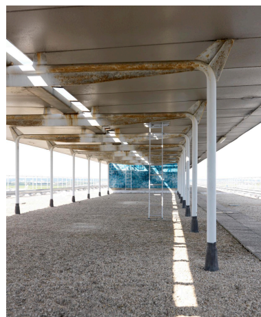
2018, auvent dessiné par Jean Prouvé, la charpente des portiques en tube d'acier porte la toiture en bacs d'aluminium qui repose sur des goussets, 6ème étage.
