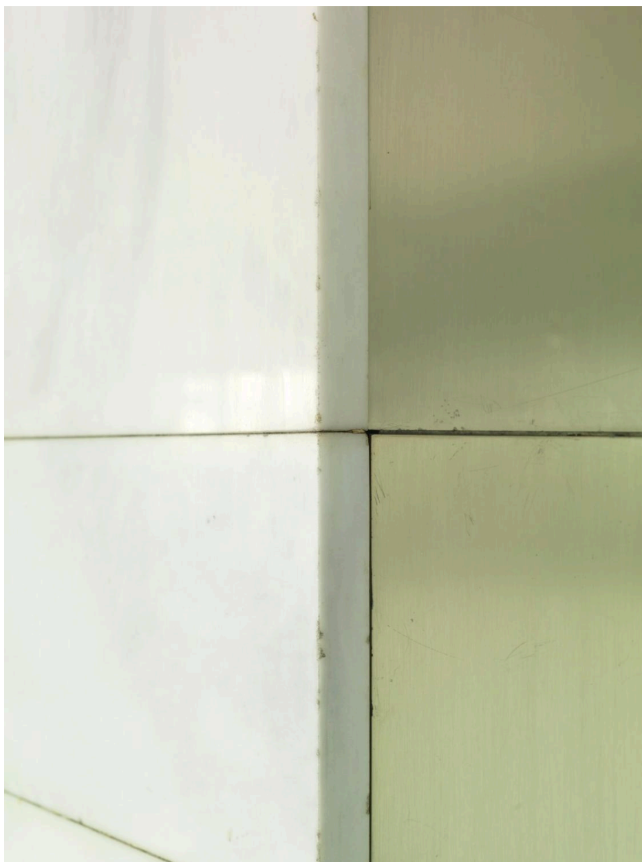
2018, poteau de la Galerie marchande, détail des parements: marbre et aluminium anodisé couleur "blond Orly", 1er étage.
