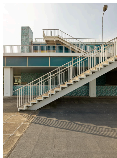
2018, terrasses, circulation verticale: escalier est, 4ème étage. Phot. Stéphane Asseline IVR11_20209400324NUC6A
