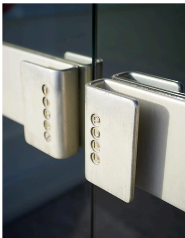
2018, poignées en aluminium d'une porte en verre du 4ème étage. Phot. Stéphane Asseline IVR11_20209400409NUC4A
