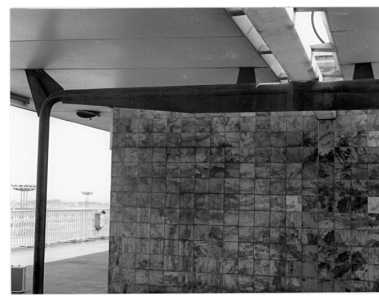
1992, auvent dessiné par Jean Prouvé, la charpente des portiques en tube d'acier porte la toiture en bacs d'aluminium qui repose sur des goussets, décor de carreaux émaillés dessinés par Claude Viseux, 6ème étage.
