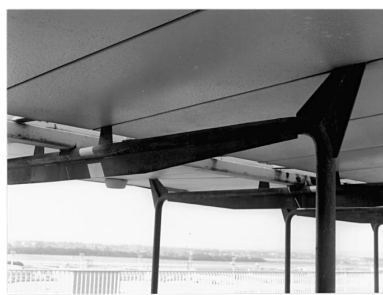
1992, auvent dessiné par Jean Prouvé, la charpente des portiques en tube d'acier porte la toiture en bacs d'aluminium qui repose sur des goussets, 6ème étage.
