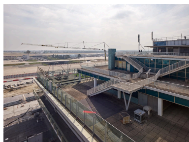
2018, terrasses, circulation verticale: escaliers est, 6ème étage. Phot. Stéphane Asseline IVR11_20209400323NUC6A
