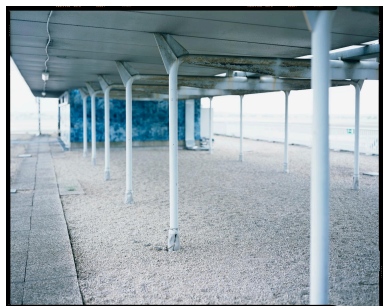
2014, auvent dessiné par Jean Prouvé, la charpente des portiques en tube d'acier porte la toiture en bacs d'aluminium qui repose sur des goussets, 6ème étage.
