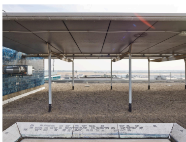
2018, table d'orientation coté nord, 6ème étage. Phot. Stéphane Asseline IVR11_20209400322NUC6A
