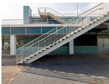
2018, terrasses, circulation verticale: escaliers est, 4ème étage. Phot. Stéphane Asseline IVR11_20209400325NUC6A
