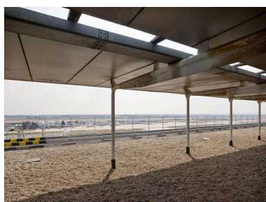
2018, auvent dessiné par Jean Prouvé, la charpente des portiques en tube d'acier porte la toiture en bacs d'aluminium qui repose sur des goussets, 6ème étage.
