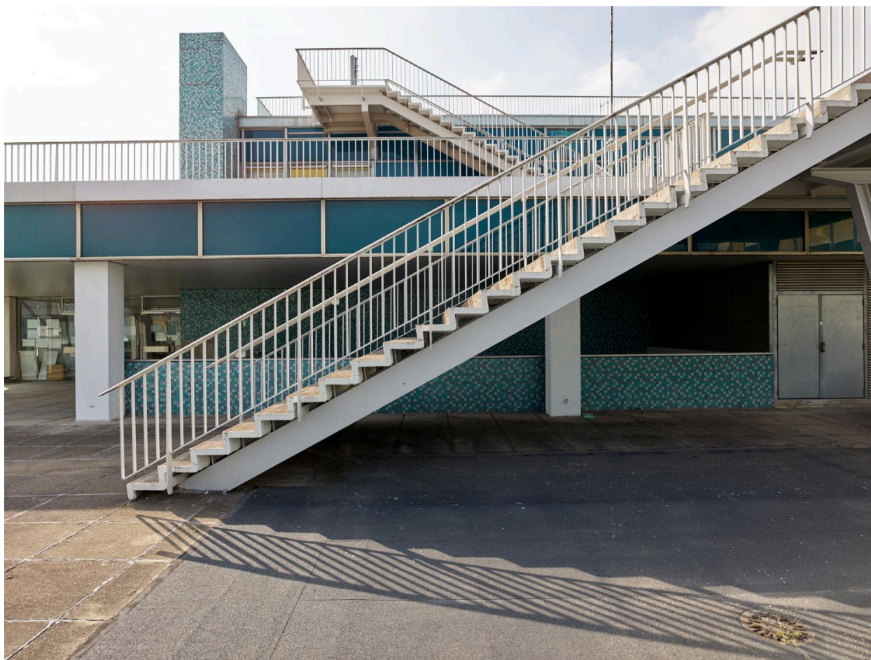
2018, terrasses, circulation verticale: escaliers est, 4ème étage.
