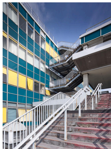
2018, terrasses, circulation verticale: escalier ouest, 4ème étage. Phot. Stéphane Asseline IVR11_20209400313NUC6A
