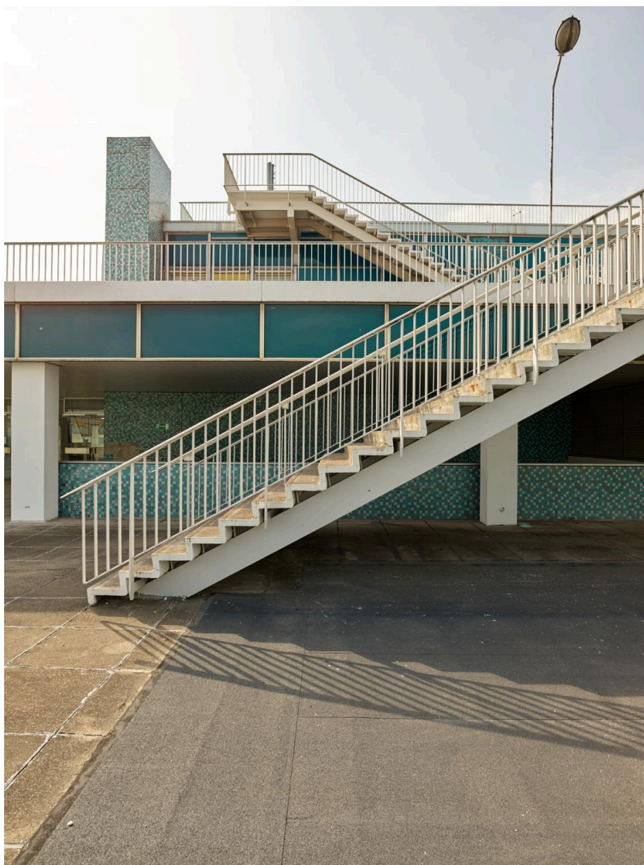
2018, terrasses, circulation verticale: escalier est, 4ème étage.
