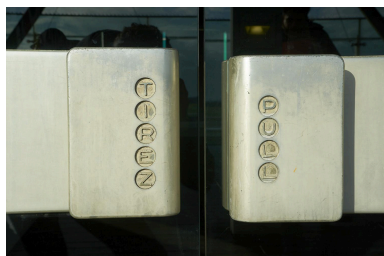
2018, poignées en aluminium d'une porte en verre du 4ème étage. Phot. Stéphane Asseline IVR11_20209400408NUC4A
