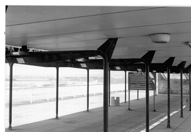
1992, auvent dessiné par Jean Prouvé, la charpente des portiques en tube d'acier porte la toiture en bacs d'aluminium qui repose sur des goussets, 6ème étage. Autr. Jean (architecte) Prouvé IVR11_19929400765X
