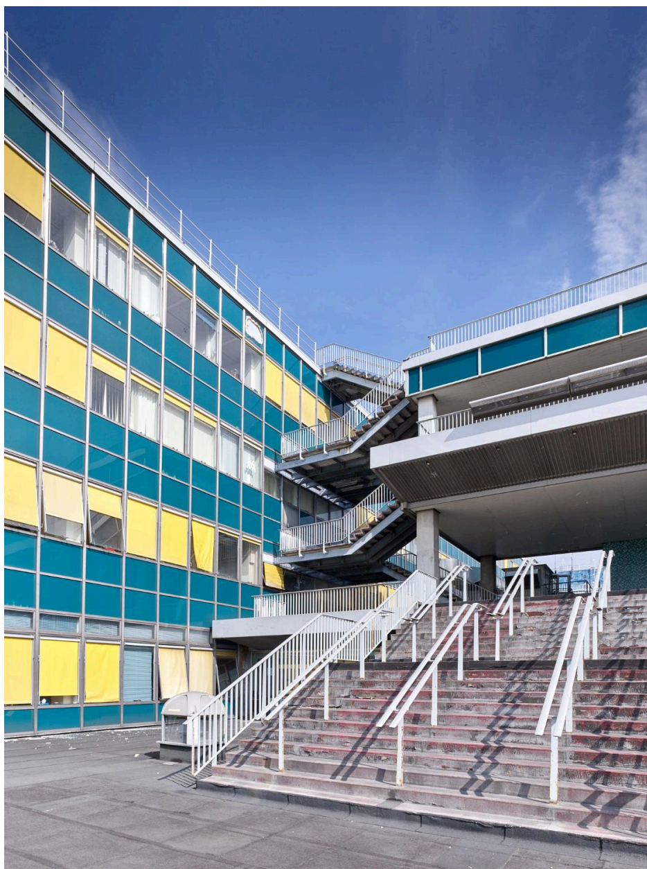
2018, terrasses, circulation verticale: escalier ouest, 4ème étage.
