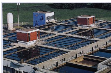
Orly, établissement des eaux dit usine de traitement des eaux d'Orly. Bassins de filtration sur sable. Tiré de : Orly. usine de traitement des eaux. In L'eau de Paris / M. Gaillard, C. Abron. Edit. Martelle, 1995. p. 154-160. Autr. Claude (photographe) Abron IVR11\_20099400096NUC4A
