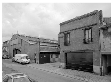
Vue générale. Phot. Jean-Bernard Vialles IVR11_20019300407X
