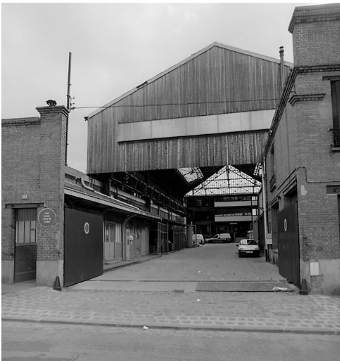
Vue de la grande halle.
