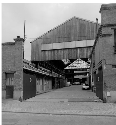
Vue de la grande halle. Phot. Jean-Bernard Vialles IVR11_20019300408X
