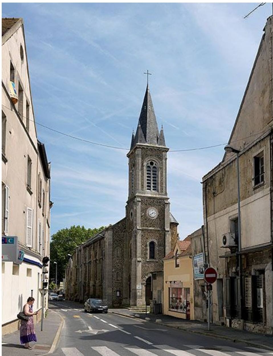
Vue extérieure d'ensemble, depuis l'ouest.
