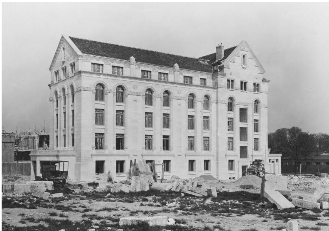
Le chantier de construction en cours d'achèvement (1930).
