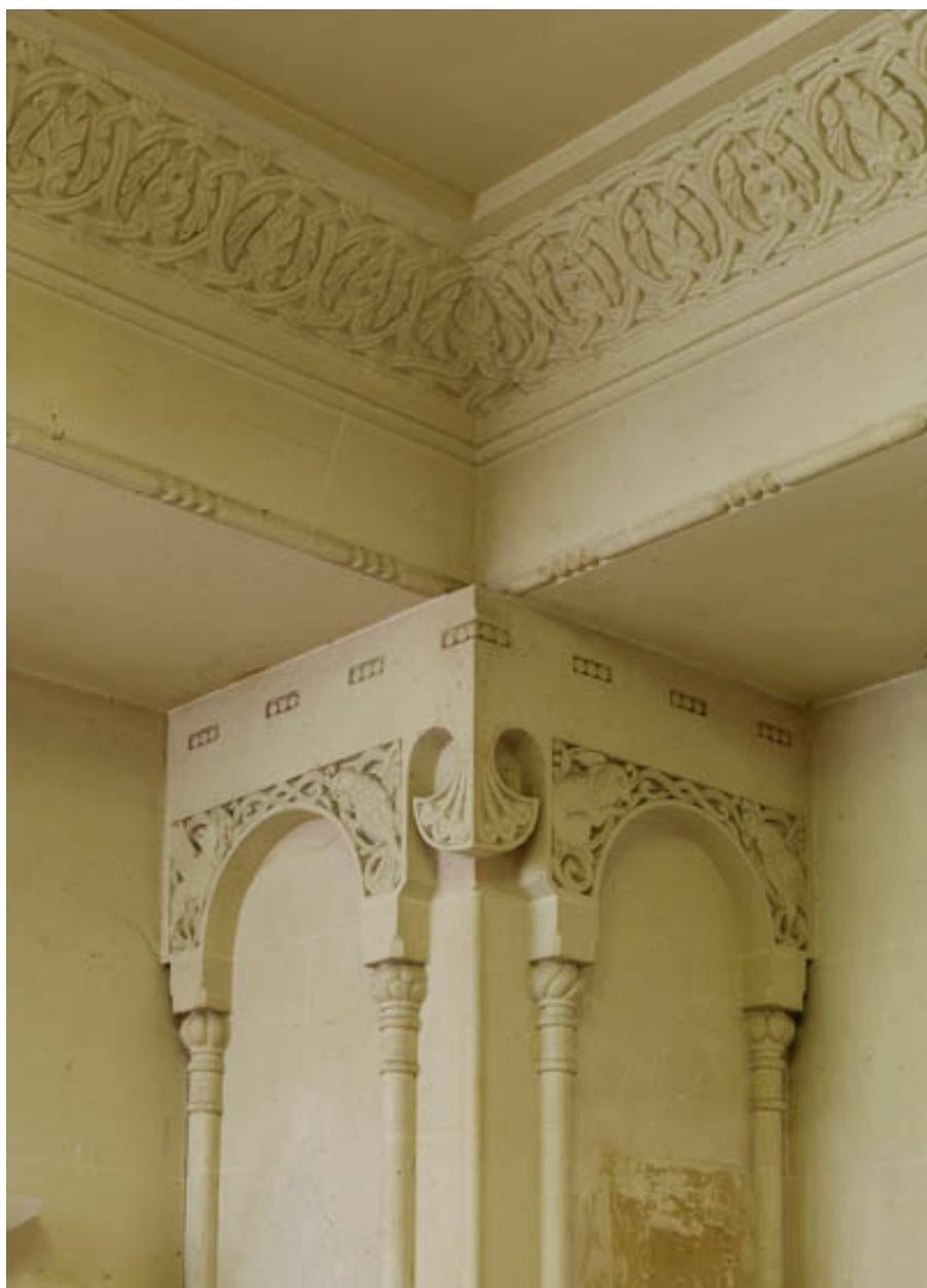
Hall d'entrée : détail du décor d'un des piliers d'angle supportant la structure.
