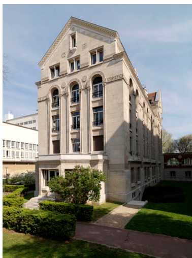
Vue du pignon sud et de la façade est. Phot. Philippe Ayrault IVR11_20107500498NUC4A
