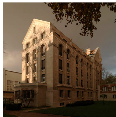
Vue d'ensemble : façade sud et façade latérale est dont le pignon est relié par une galerie couverte à la Maison des Provinces de France. Phot. Philippe Ayrault IVR11_20107501164NUC4A
