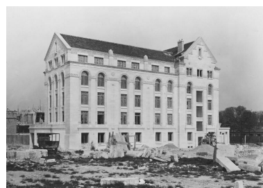
Le chantier de construction en cours d'achèvement (1930). IVR11_20107501176NUC4A
