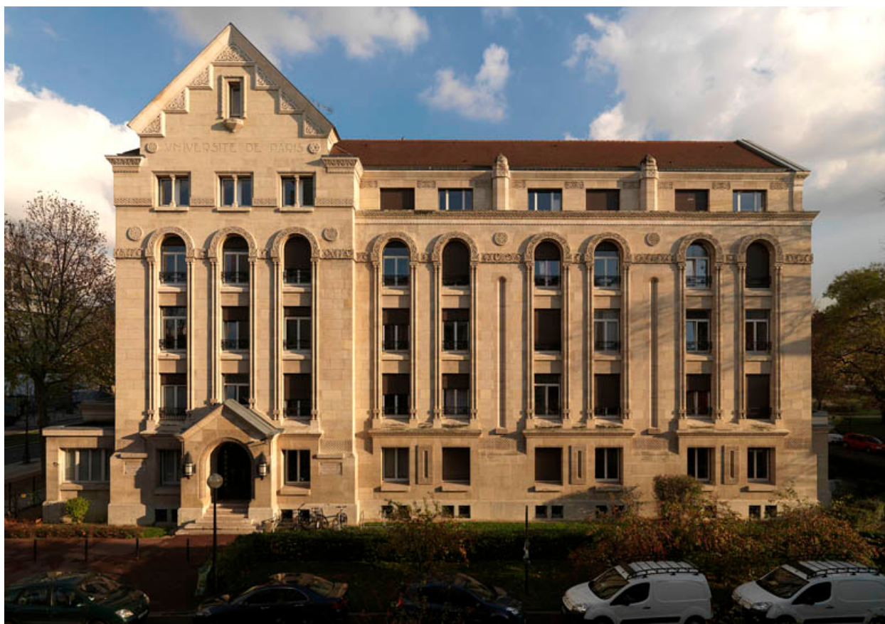
Façade principale : vue d'ensemble.
