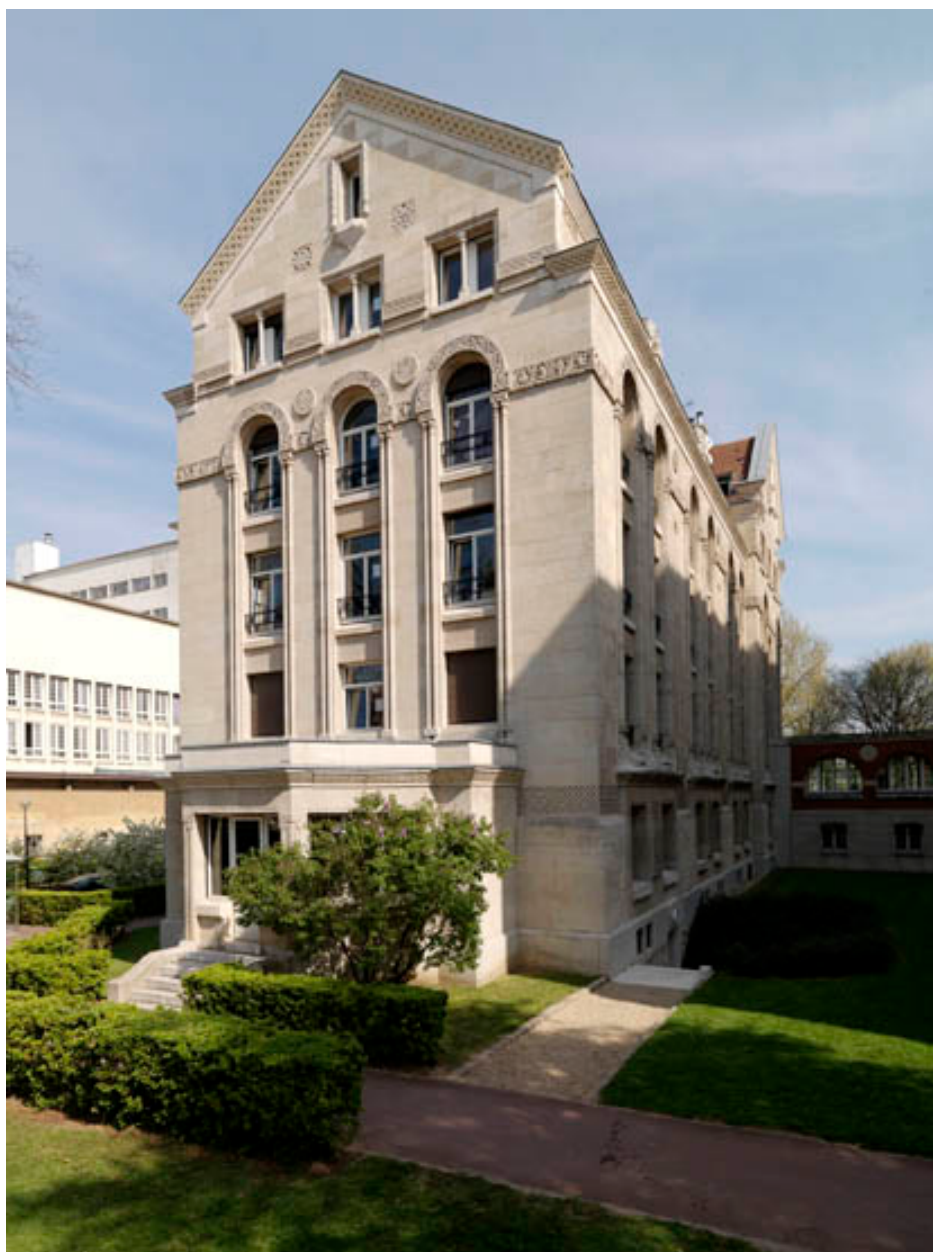
Vue du pignon sud et de la façade est.
