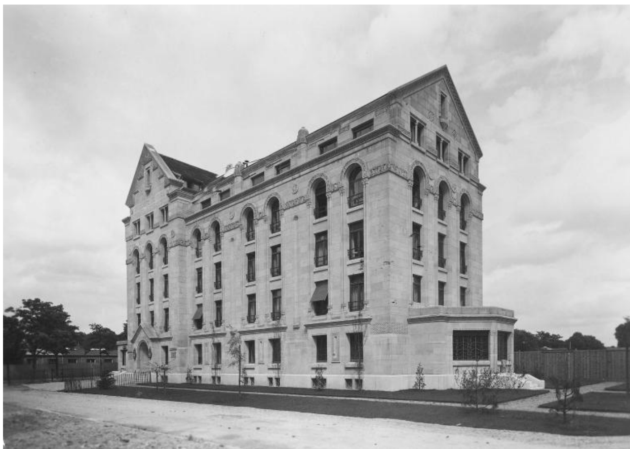
Vue d'ensemble du bâtiment, prise du sud-ouest. S. d. (vers 1933).
