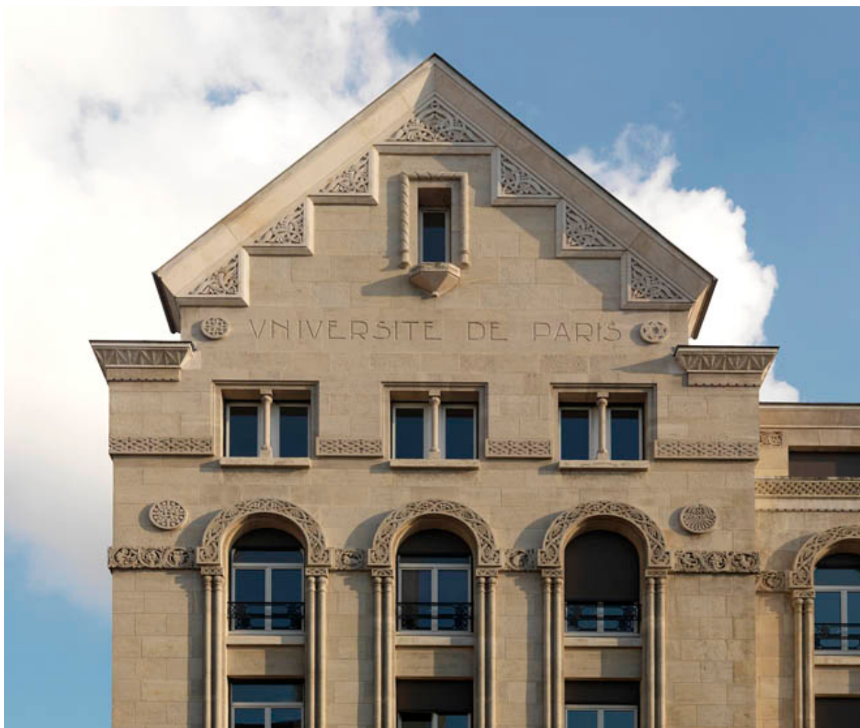
Vue du pignon de la façade ouest.
