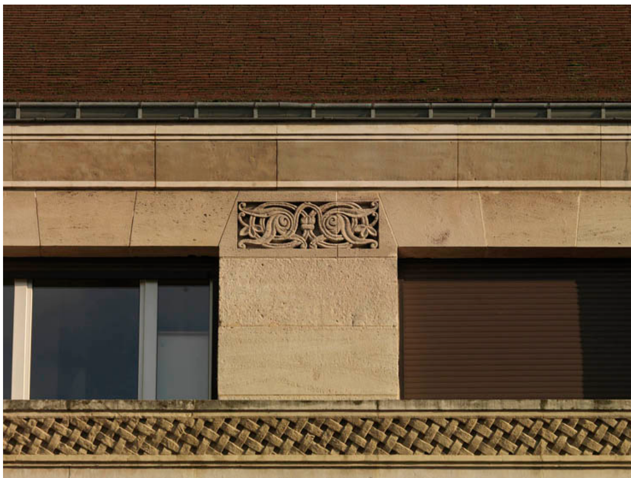
Détail du motif de vannerie de la corniche supérieure et du décor d'entrelacs placé entre les travées doubles du 4e étage.
