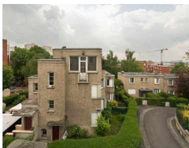
Vue d'ensemble, place Henri Sellier Phot. Laurent Kruszyk IVR11_20179300316NUC4A
