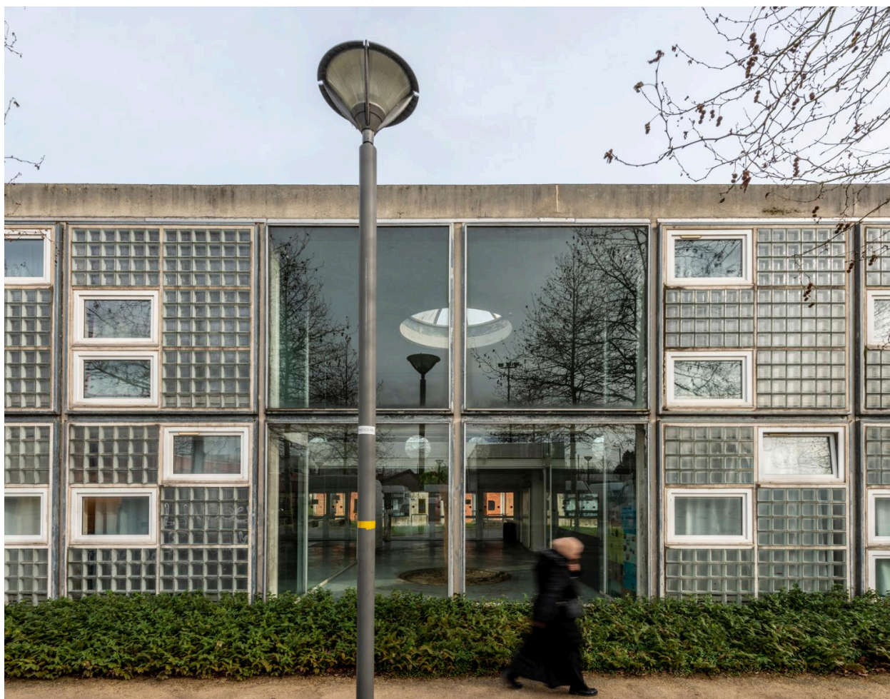
Détail de la façade vitrée de l'extension du lycée, réalisée à la fin des années 1980.
