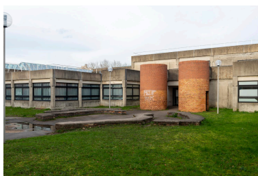
Le dessin du mobilier extérieur en béton fait écho aux formes géométriques des bâtiments.
