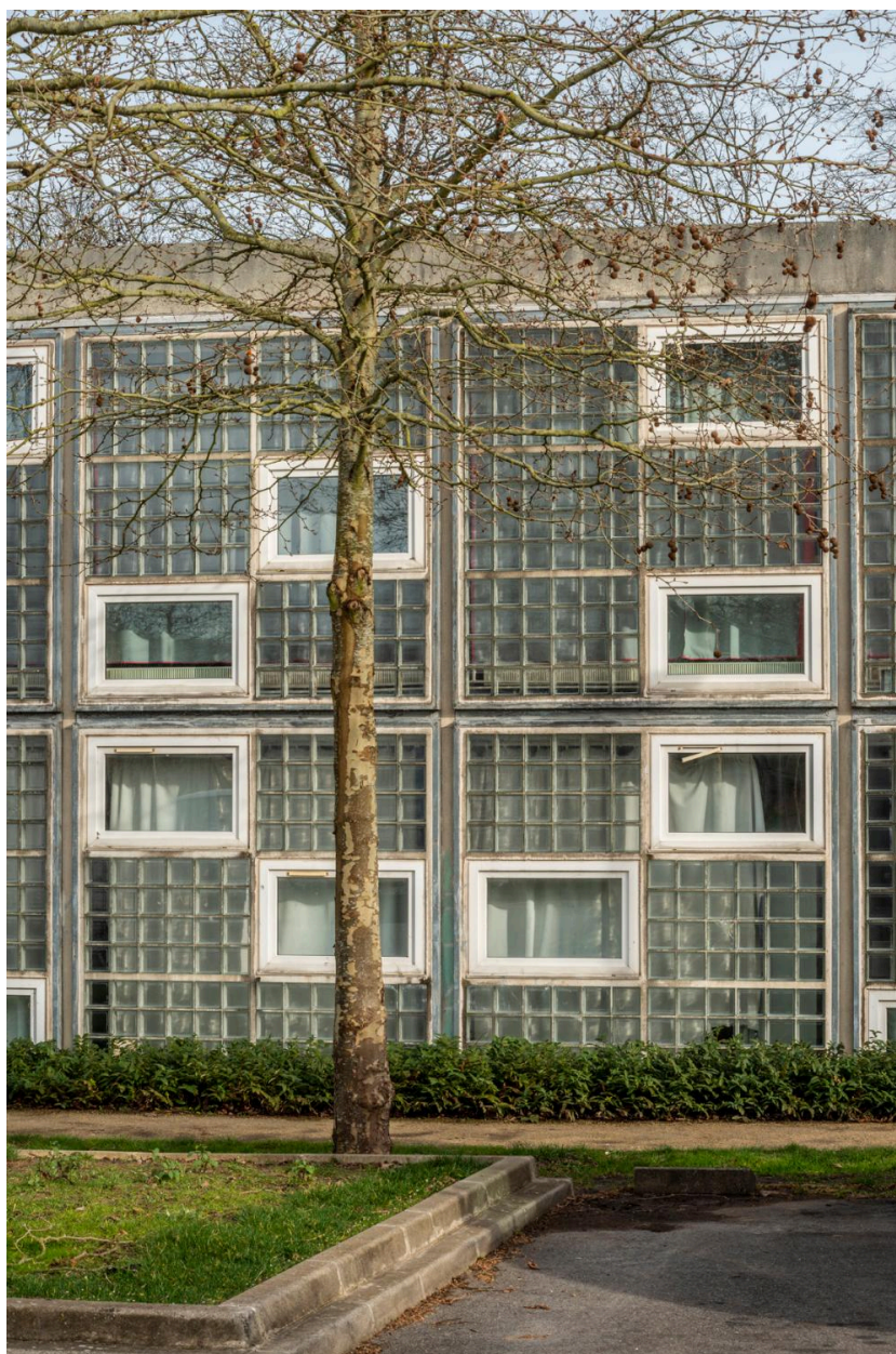
Détail de la façade vitrée de l'extension du lycée, érigée à la fin des années 1980.
