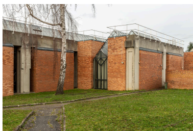
Les huisseries en aluminium anodisé noir contrastent avec les parements de brique rouge. Phot. Laurent Kruszyk IVR11_20207700284NUC4A
