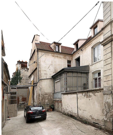
Les bâtiments sur cour. Phot. Jean-Bernard Vialles IVR11_20137700265NUC4A
