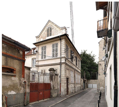
Vue générale, depuis la rue. Phot. Jean-Bernard Vialles IVR11_20137700264NUC4A
