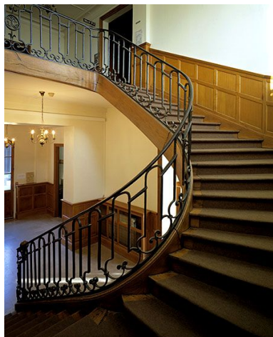
L'escalier d'honneur : vue d'ensemble, depuis le repos. Phot. Stéphane Asseline IVR11_20027701012VA
