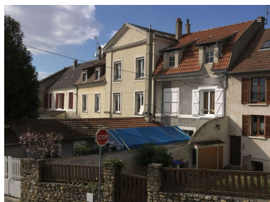
Façade antérieure. Phot. Laurent Kruszyk IVR11_20087800123NUC4A
