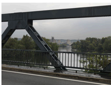
Poutres en treillis et garde-corps du pont.
