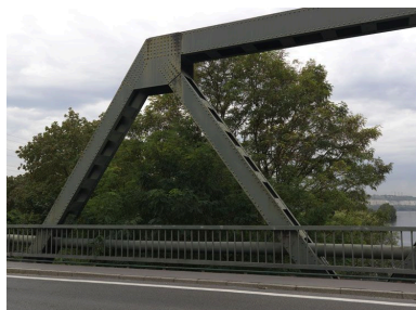
Début du treillis vu depuis le pont vers l'aval.
