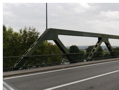
Poutres métalliques en treillis vues depuis le pont vers l'amont.
