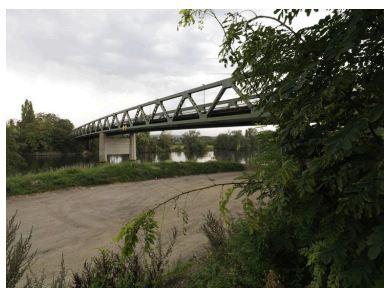
Première travée de l'ouvrage qui s'appuie sur une pile en béton, vue depuis les berges d'Épône.
