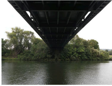
Poutres métalliques du tablier vus depuis les berges. Phot. Laurent Kruszyk IVR11_20117800241NUC4A
