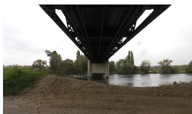
Pile intermédiaire du pont en béton vue depuis le chemin de terre sur la rive d'Épône.
