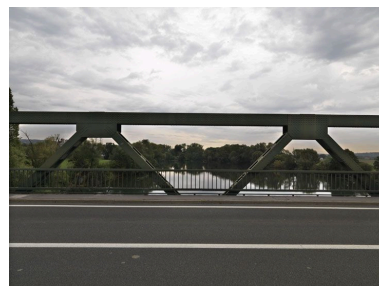
Poutres métalliques du pont et garde-corps. On aperçoit le début d'un méandre du bras de la Seine.
