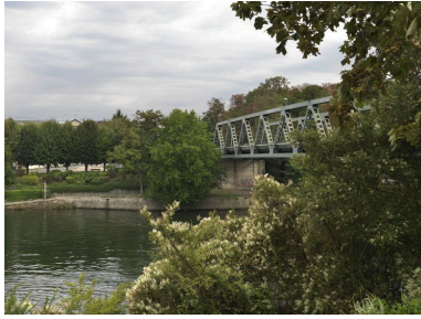
Poutres métalliques en treillis Warren vues depuis les berges de l'Île de Rangipont. On aperçoit la culée en béton sur les berges. Phot. Laurent Kruszyk IVR11_20117800237NUC4A
