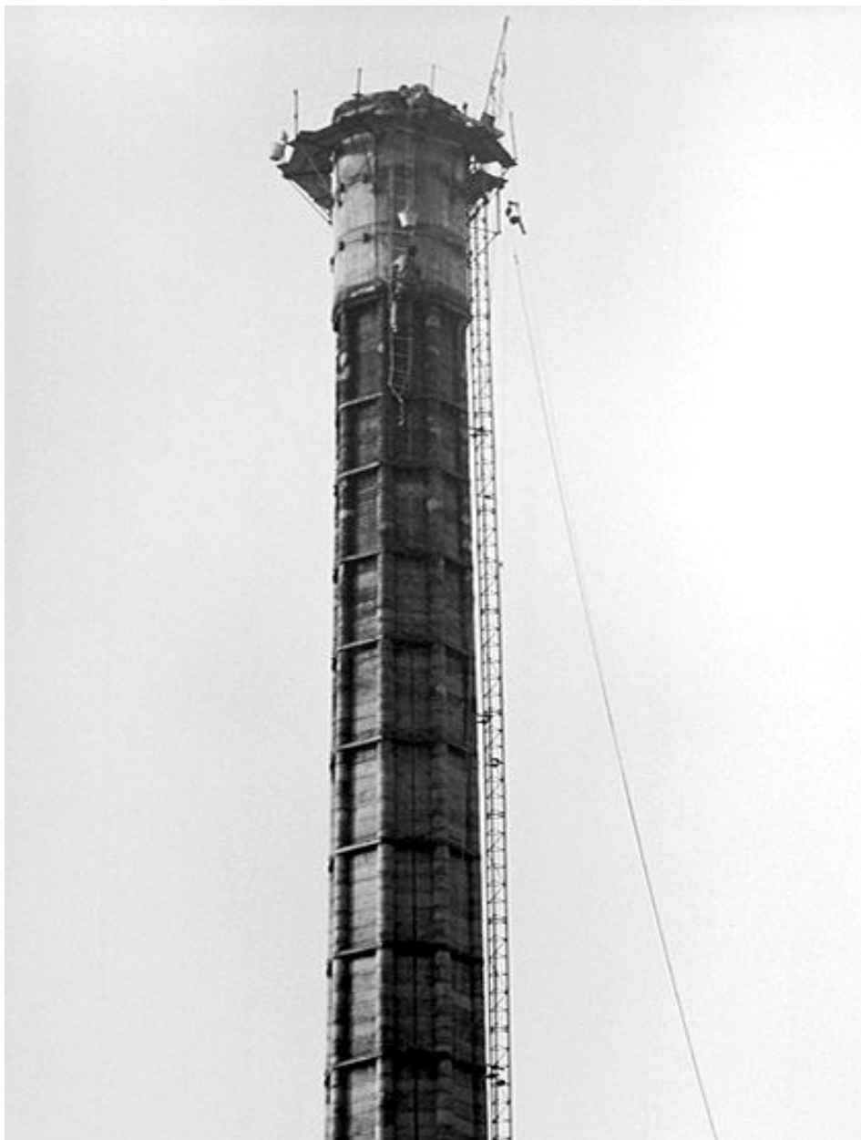
La cheminée, peu avant sa démolition. Photographie. (Collection particulière (M. Bouvet, à Melun))
