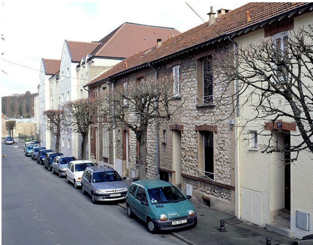
Maisons ouvrières de la rue Dajot, dépendant de l'ancienne usine Vernin (détruite).
