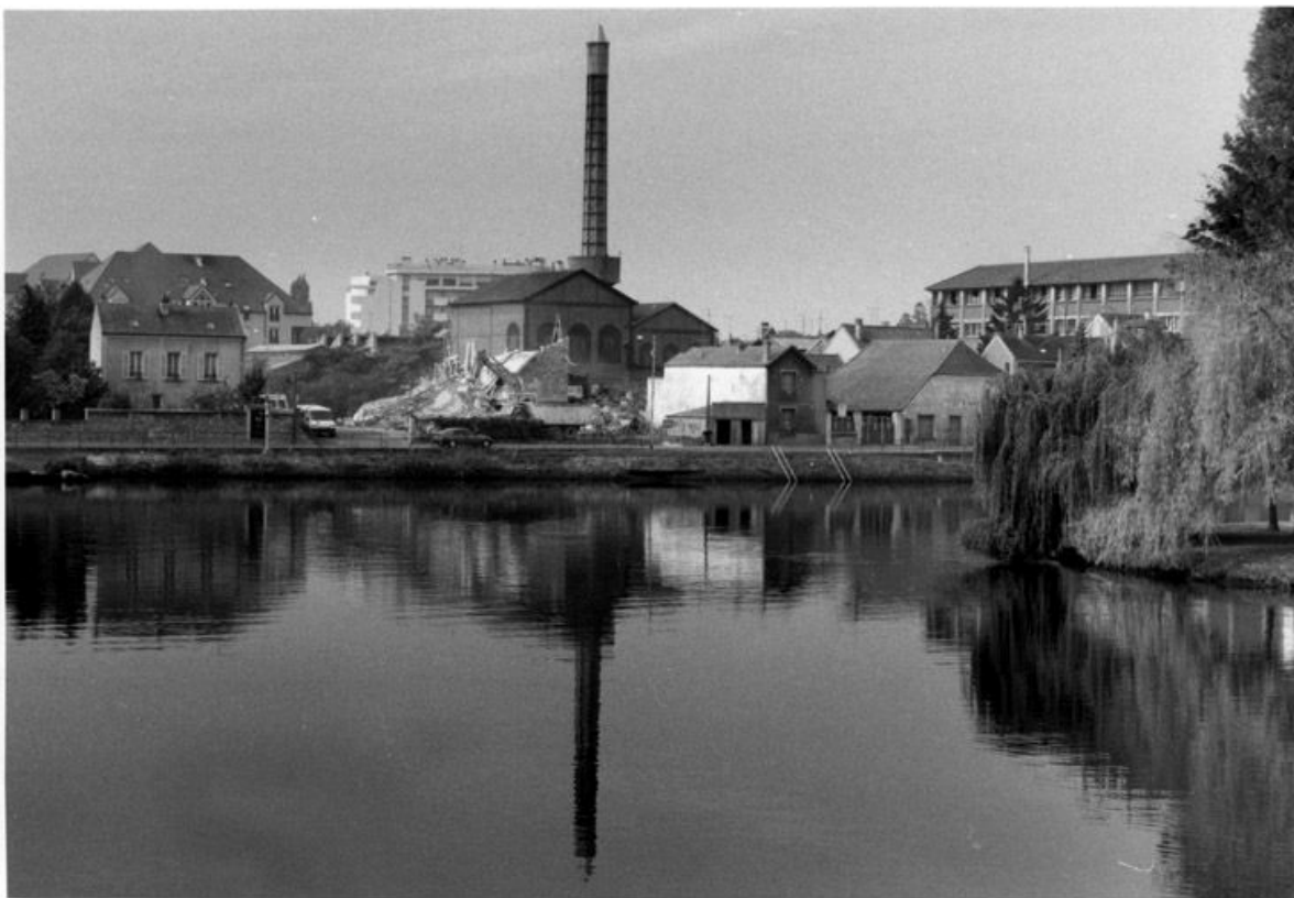
Vue d'ensemble, depuis le nord-est : le front de Seine. L'immeuble d'habitation à l'est est en cours de démolition. 5 octobre 1997. (Collection particulière)
