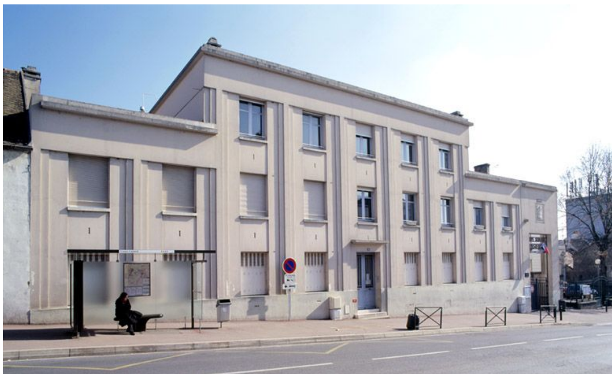
Vue générale, depuis la rue du Général-de-Gaulle.
