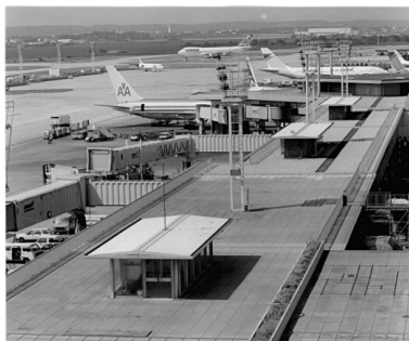
1992, terrasse de la jetée ouest, 4ème étage. Phot. Christian Décamps IVR11_19929400753X
