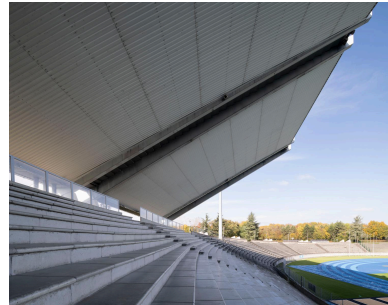
Détail du porte-à-faux de la tribune, culminant à 32 m. Phot. Philippe Ayrault IVR11_20229100727NUC4A
