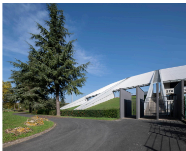
Détail des refends de béton en forme d'équerres sur lesquels repose la tribune. Phot. Philippe Ayrault IVR11_20229100733NUC4A
