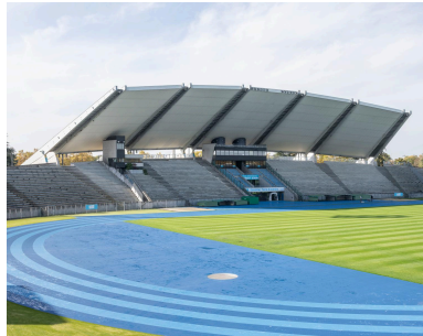
Vue générale du stade Robert-Bobin. Phot. Philippe Ayrault IVR11_20229100721NUC4A
