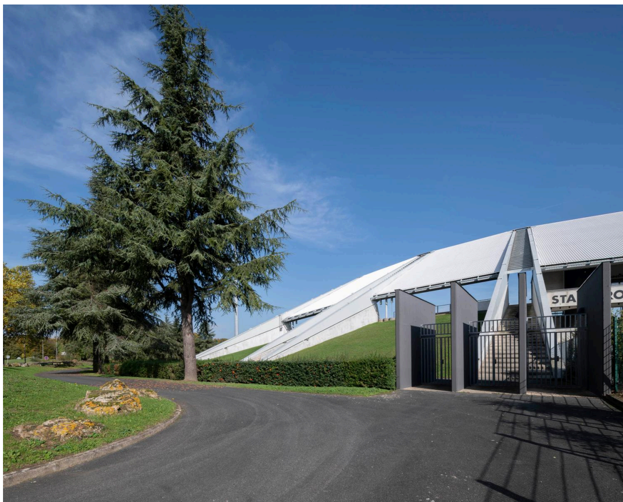
Détail des refends de béton en forme d'équerres sur lesquels repose la tribune.
