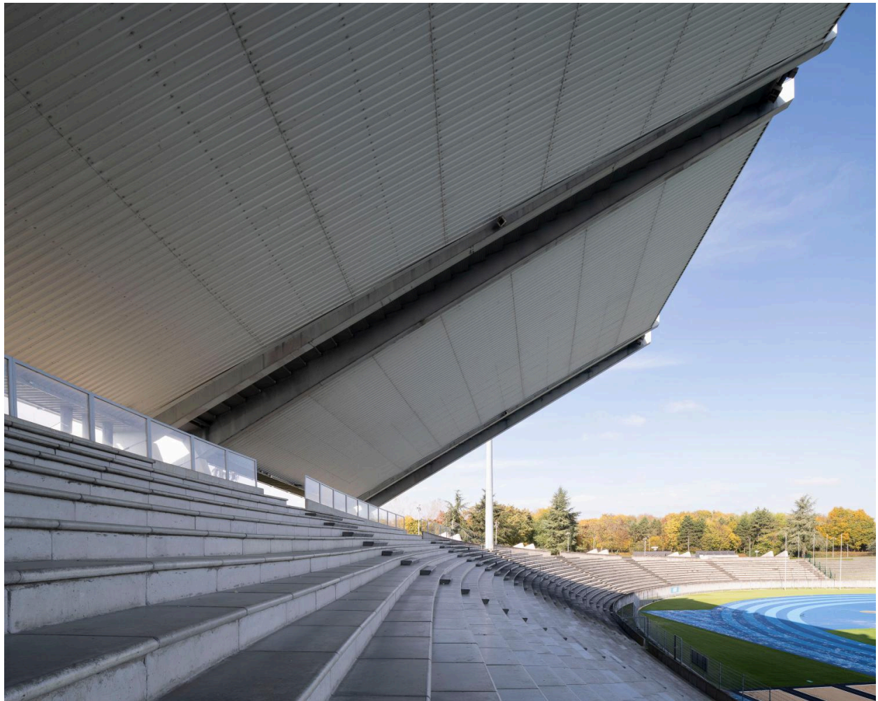
Détail du porte-à-faux de la tribune, culminant à 32 m.
