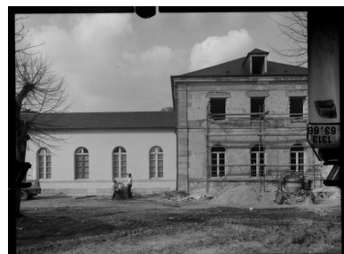
Pavillon en cours de restauration.
