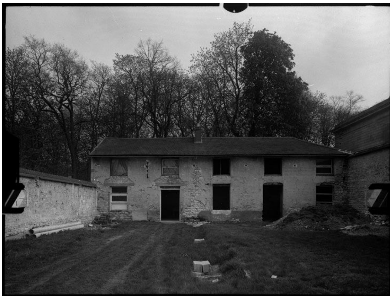
Pavillon en cours de restauration.
