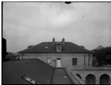
Couverture de la galerie le long du vestibule. Phot. Atelier de photogrammétrie de l'Inventaire, Phot. Jean-Bernard Vialles IVR11_19857802007G
