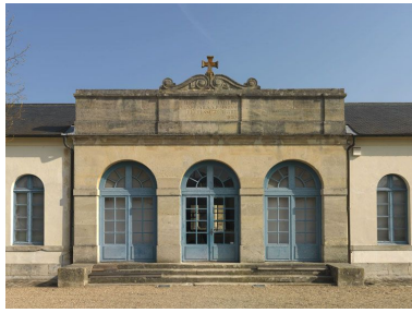
Le corps central de la façade d'entrée qui abrite le vestibule. Phot. Laurent Kruszyk IVR11_20127800200NUC4A
