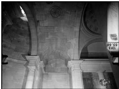
Voûte de la travée droite du chœur.
