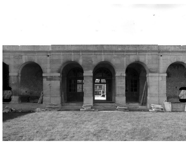
Le vestibule d'entrée et la galerie côté cour.
