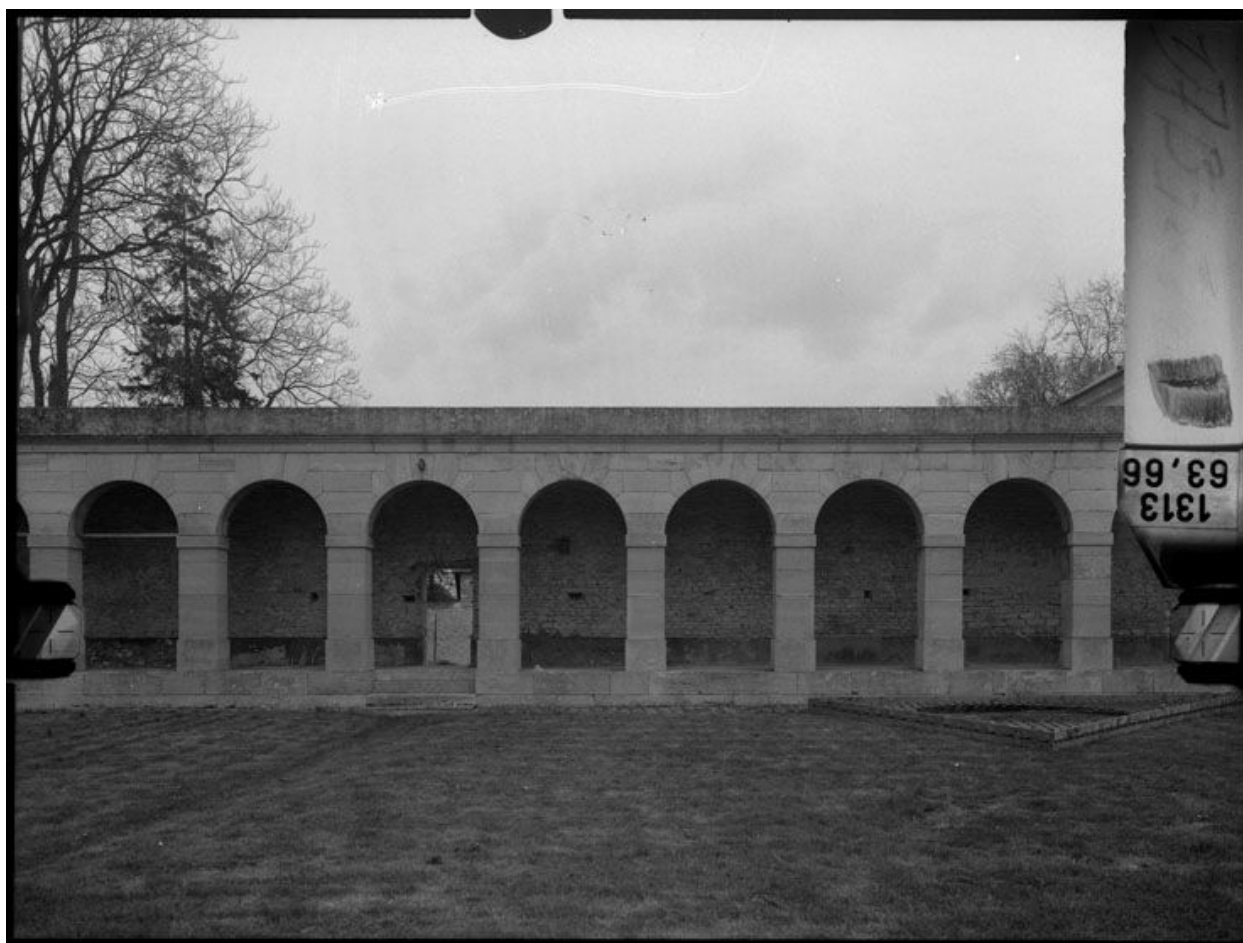
Détail de la galerie.
