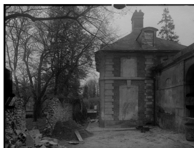
Le pavillon du médecin. Phot. Atelier de photogrammétrie de l'Inventaire, Phot. Jean-Bernard Vialles IVR11_19857802015G
