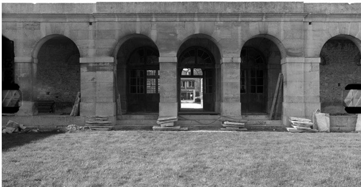
Le vestibule d'entrée et la galerie côté cour.
