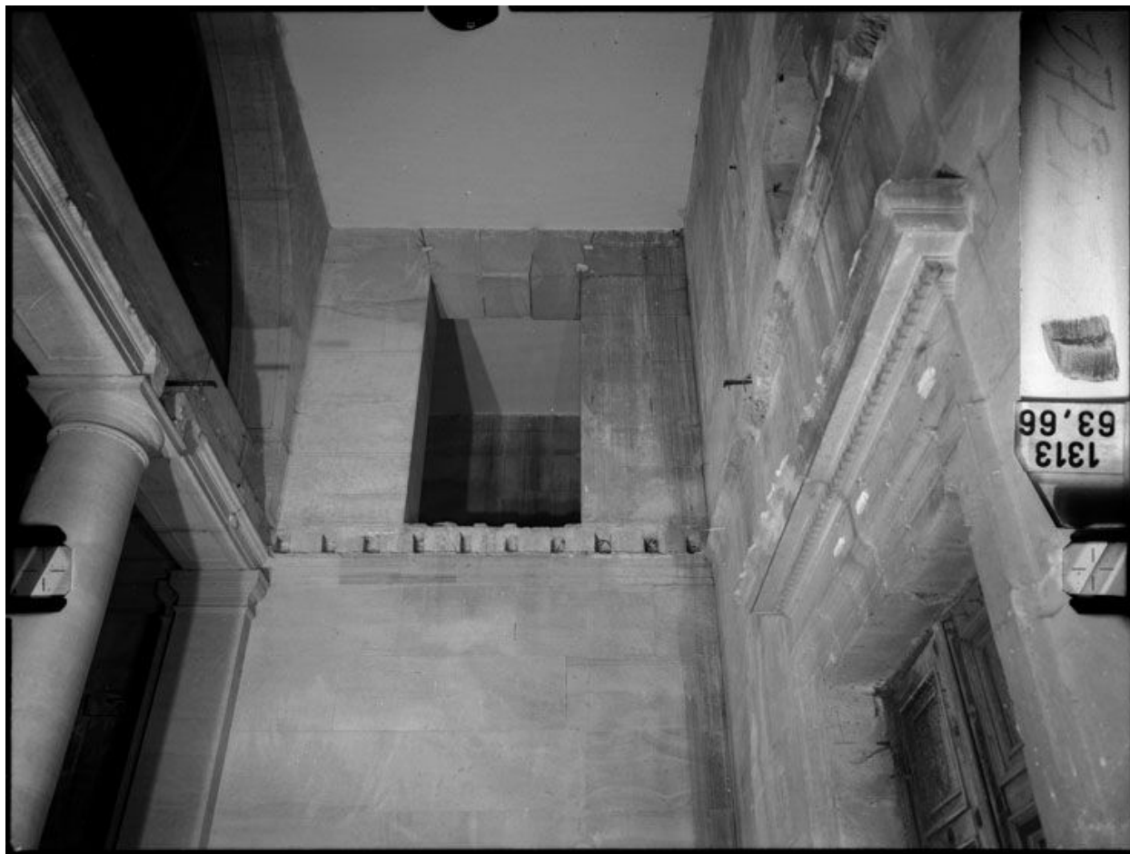
Partie haute du chœur.
