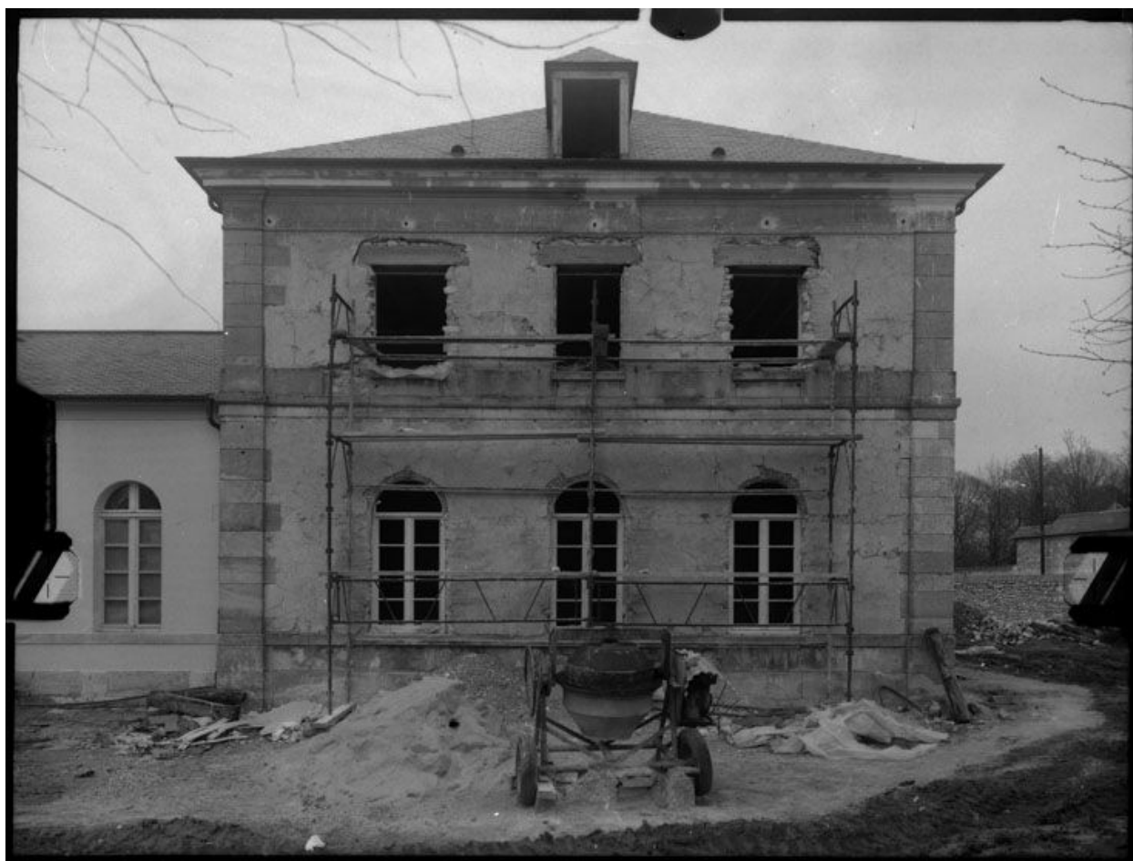
Pavillon en restauration.
