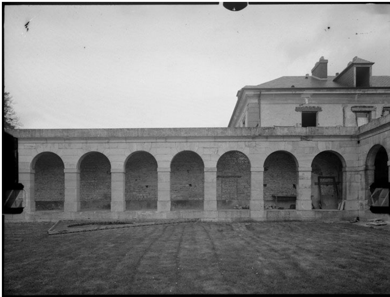
Détail de la galerie.
