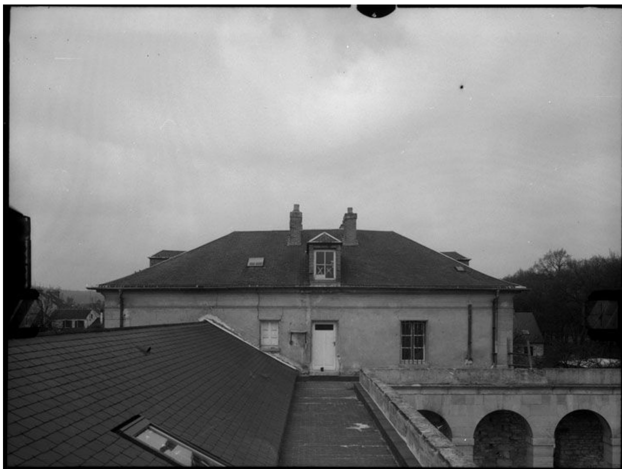
Couverture de la galerie le long du vestibule.
