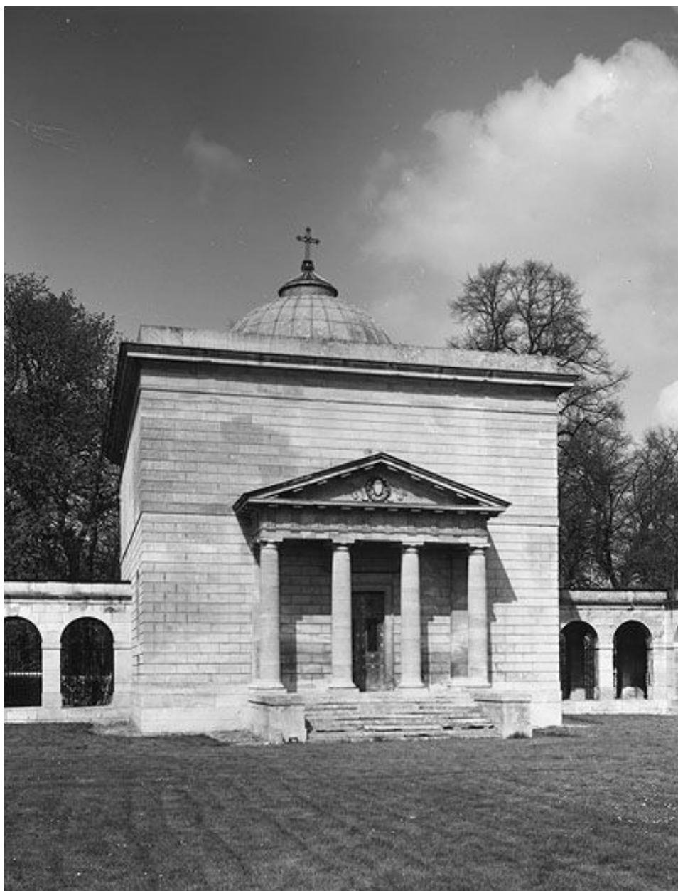
Façade principale de la chapelle.
