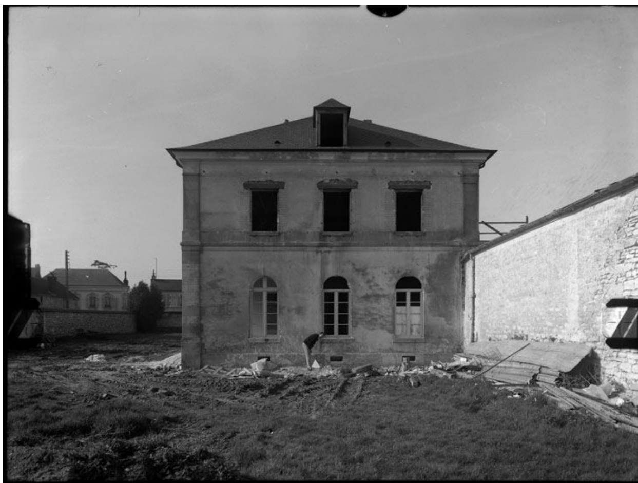
Pavillon en cours de restauration.
