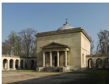
La chapelle, façade principale. Phot. Laurent Kruszyk IVR11_20127800204NUC4A
