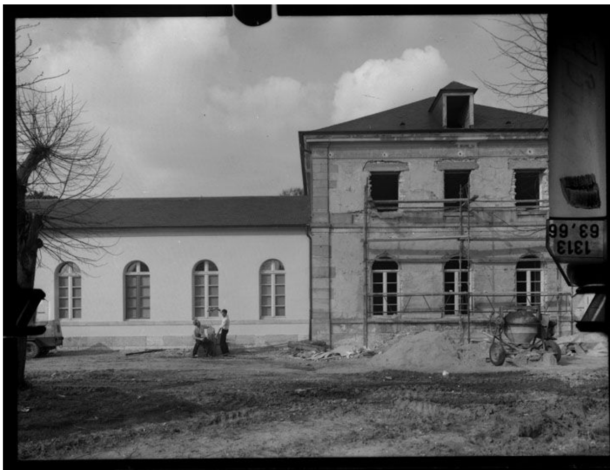
Pavillon en cours de restauration.
