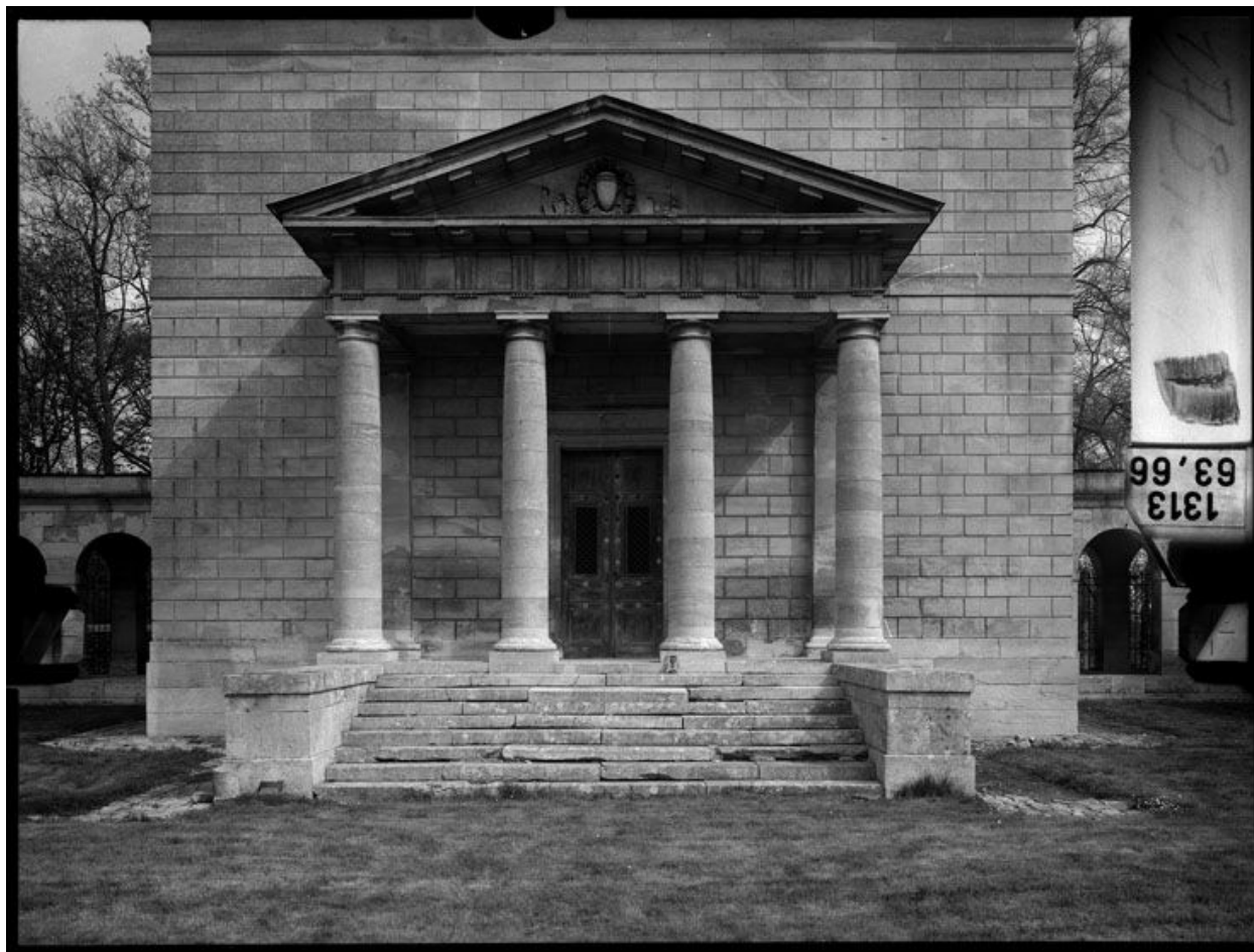
Porche d'entrée de la chapelle.
