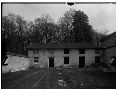
Pavillon en cours de restauration. Phot. Atelier de photogrammétrie de l'Inventaire, Phot. Jean-Bernard Vialles IVR11_19857802013G
