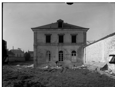
Pavillon en cours de restauration. Phot. Atelier de photogrammétrie de l'Inventaire, Phot. Jean-Bernard Vialles IVR11_19857802028G
