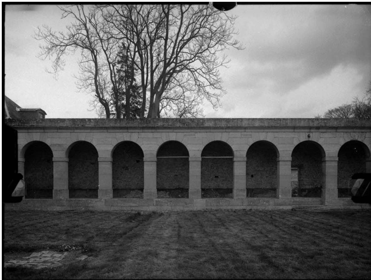
Détail de la galerie.
