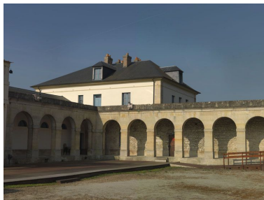
Détail de la galerie occidentale et de la galerie en retour sur l'hospice. Phot. Laurent Kruszyk IVR11_20127800209NUC4A
