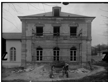
Pavillon en restauration.
