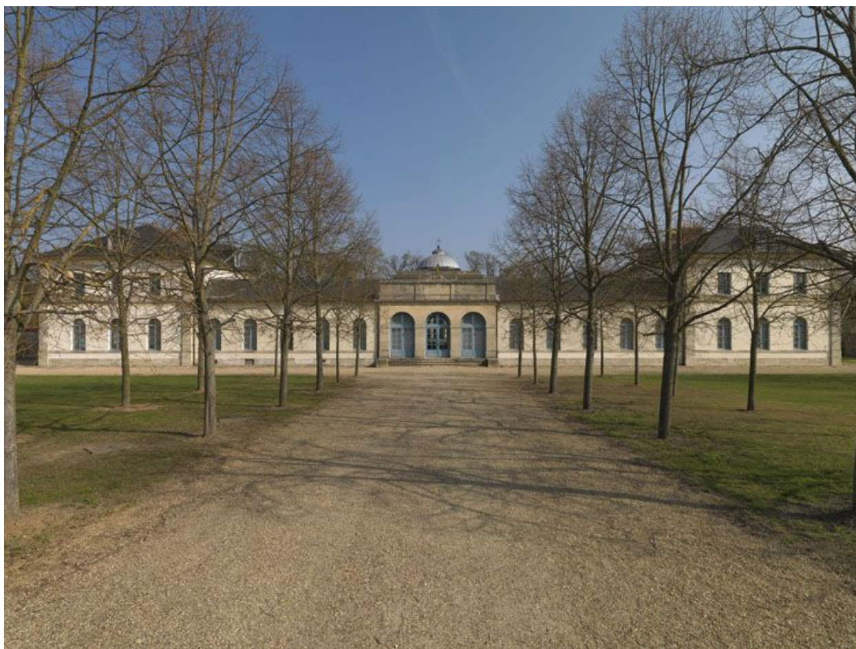
Vue d'ensemble de la façade d'entrée.
