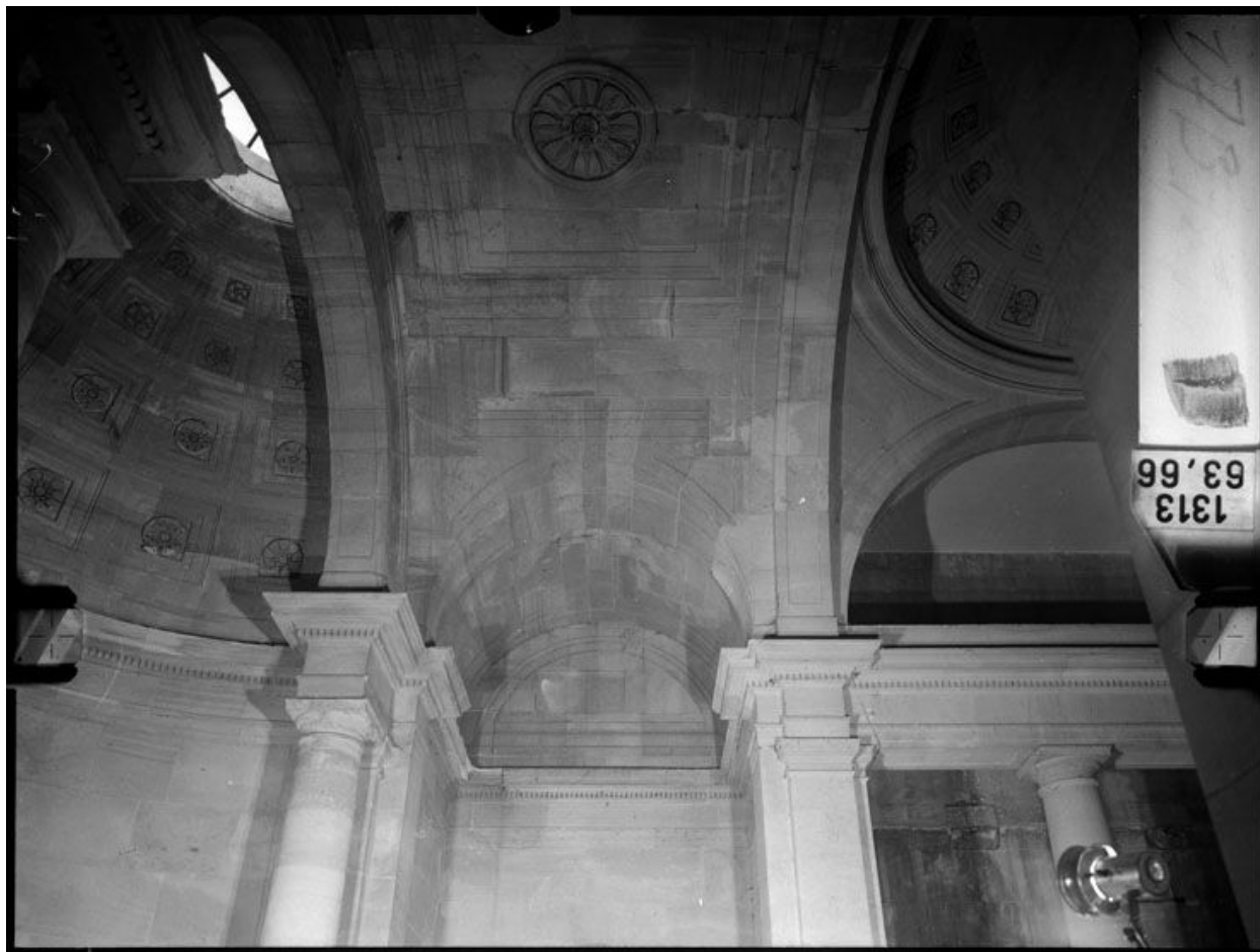
Voûte de la travée droite du chœur.
