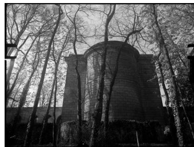
Façade arrière de la chapelle. Phot. Atelier de photogrammétrie de l'Inventaire, Phot. Jean-Bernard Vialles IVR11_19857802021G
