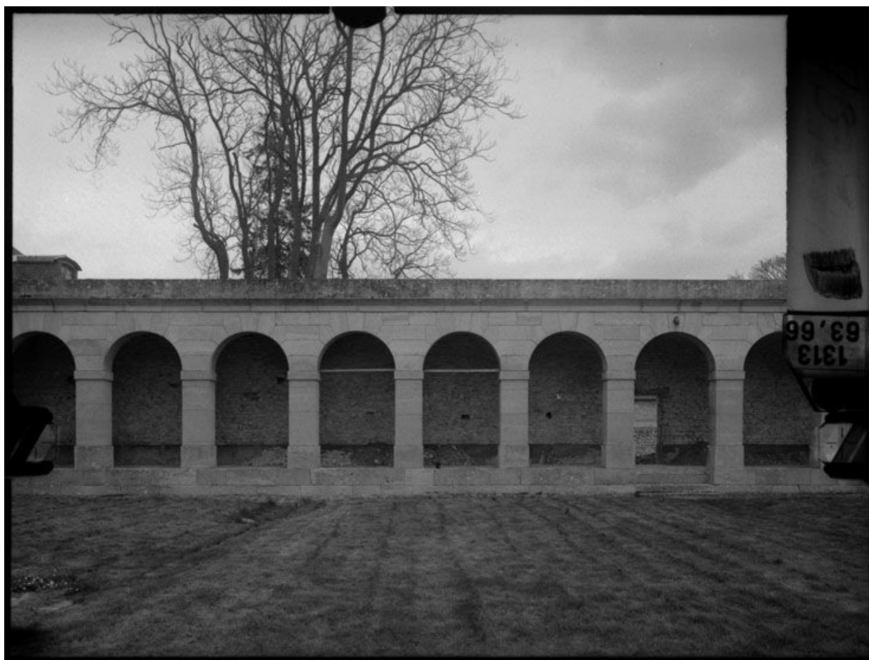
Détail de la galerie.
