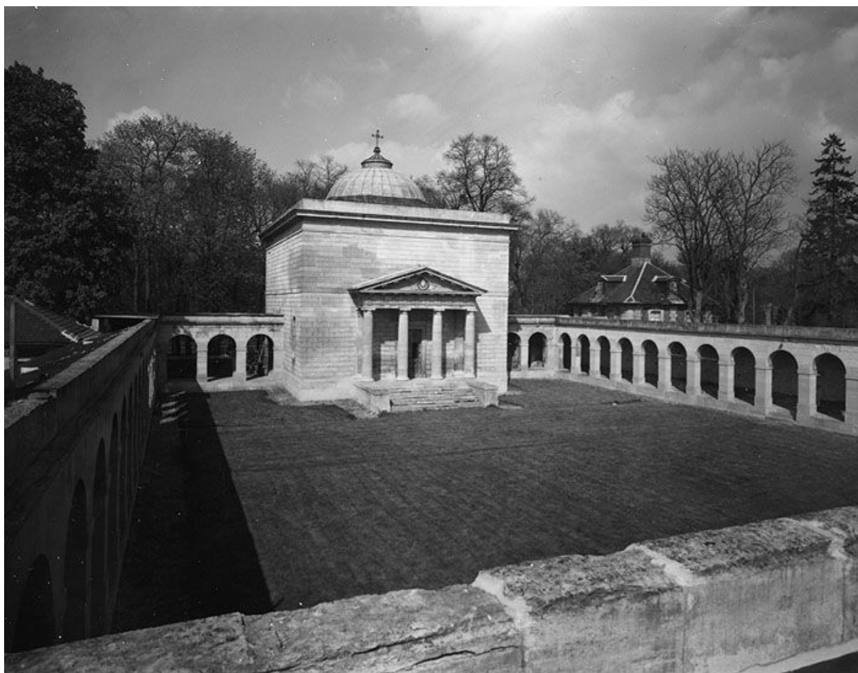
Façade principale de la chapelle et la galerie.
