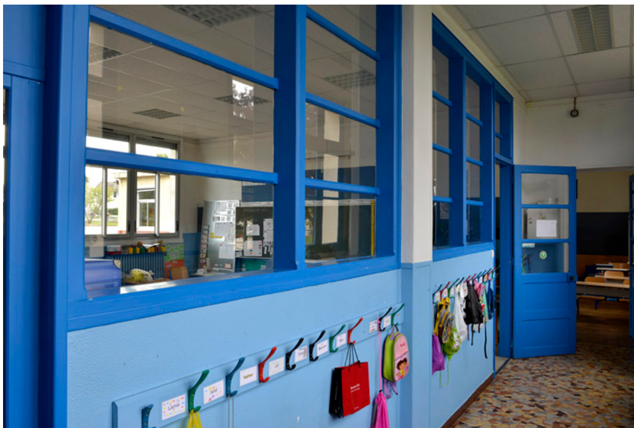
Couloir et classe à l'intérieur du bâtiment.
