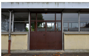
Une des classes "Prouvé", la porte d'entrée. Phot. Laurent Kruszyk IVR11_20137800382NUC4A
