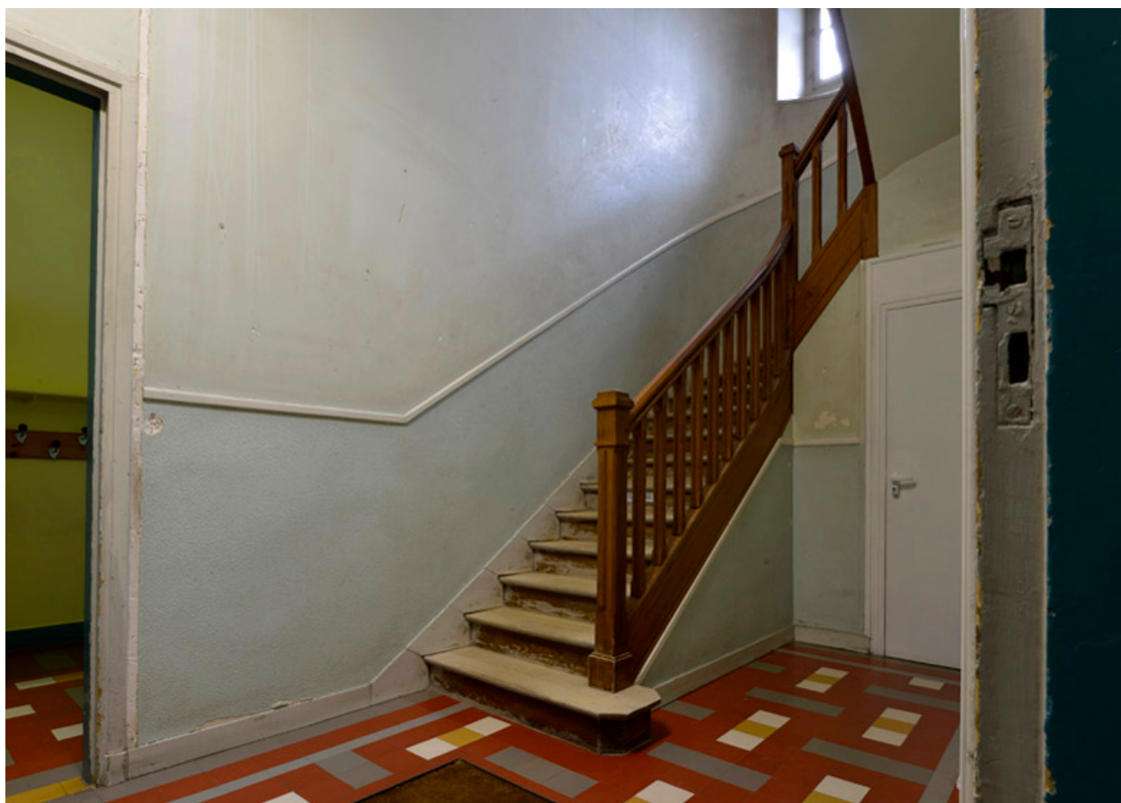
Un des escaliers desservant l'étage.
