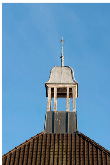
Le campanile. Phot. Laurent Kruszyk IVR11_20137800485NUC4A
