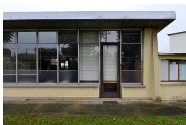
Une des classes "Prouvé", la porte d'entrée. Phot. Laurent Kruszyk IVR11_20137800384NUC4A
