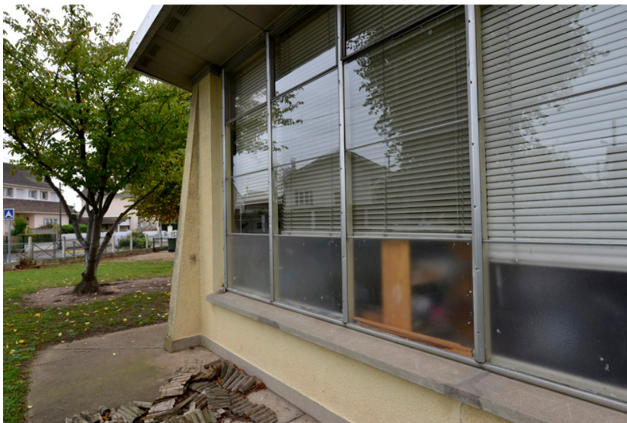
Une des classes "Prouvé", détail des huisseries en aluminium.
