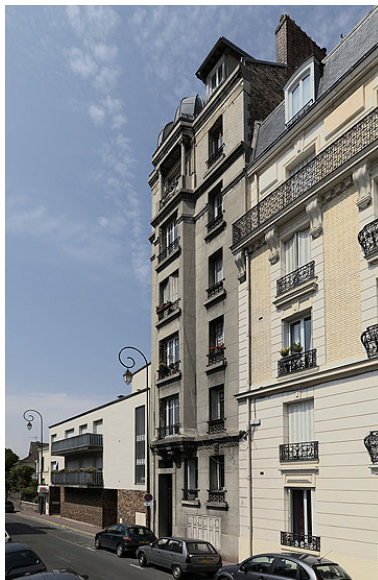
Vue d'ensemble de l'édifice construit en 1923. Phot. Jean-Bernard Vialles IVR11_20089500360NUC4A
