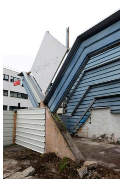
Détail de la façade latérale. Phot. Laurent Kruszyk IVR11_20169200289NUC4A
