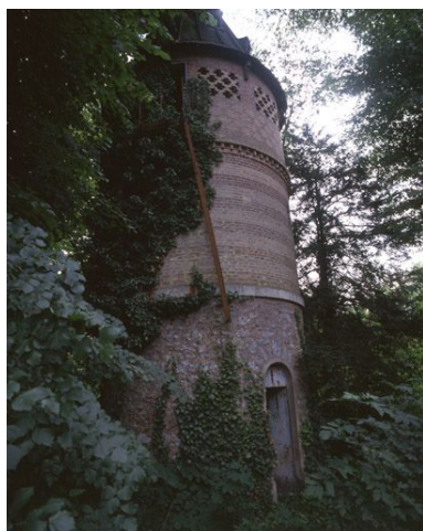
Vue rapprochée du château d'eau. Phot. Philippe Ayrault IVR11_20079100849XA
