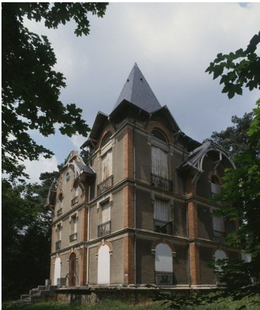
Façades antérieure et latérale.
