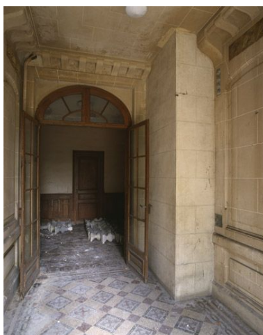
Hall d'entrée. Phot. Philippe Ayrault IVR11_20079100841XA
