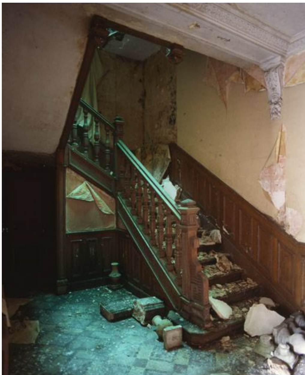
Escalier situé à droite du hall d'entrée.
