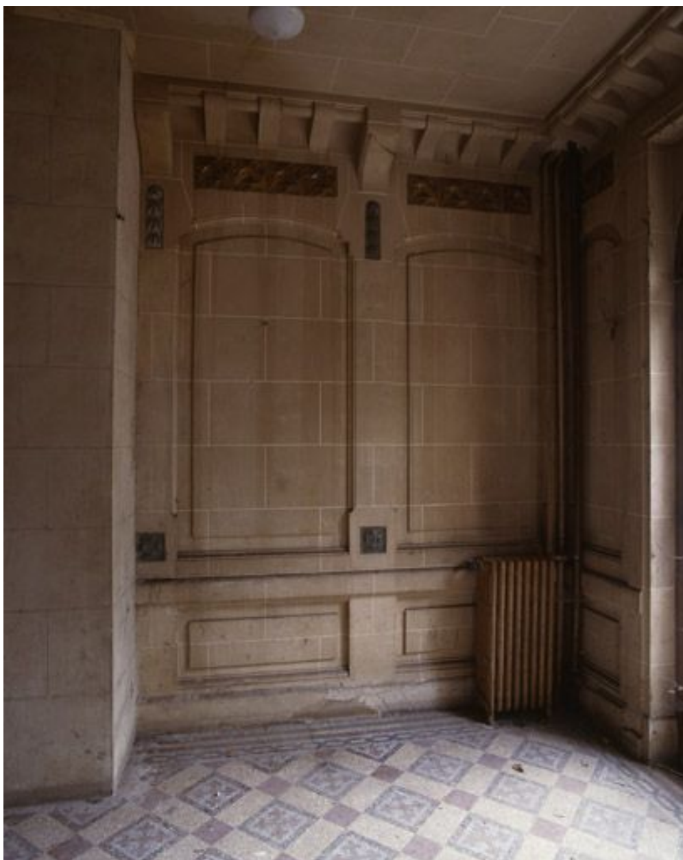
Mur latéral du hall d'entrée.
