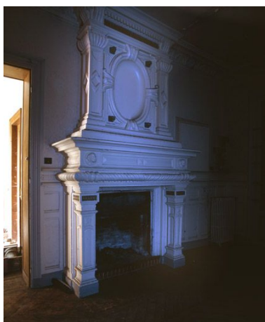
Cheminée d'une des pièces du rez-de-chaussée. Phot. Philippe Ayrault IVR11_20079100847XA
