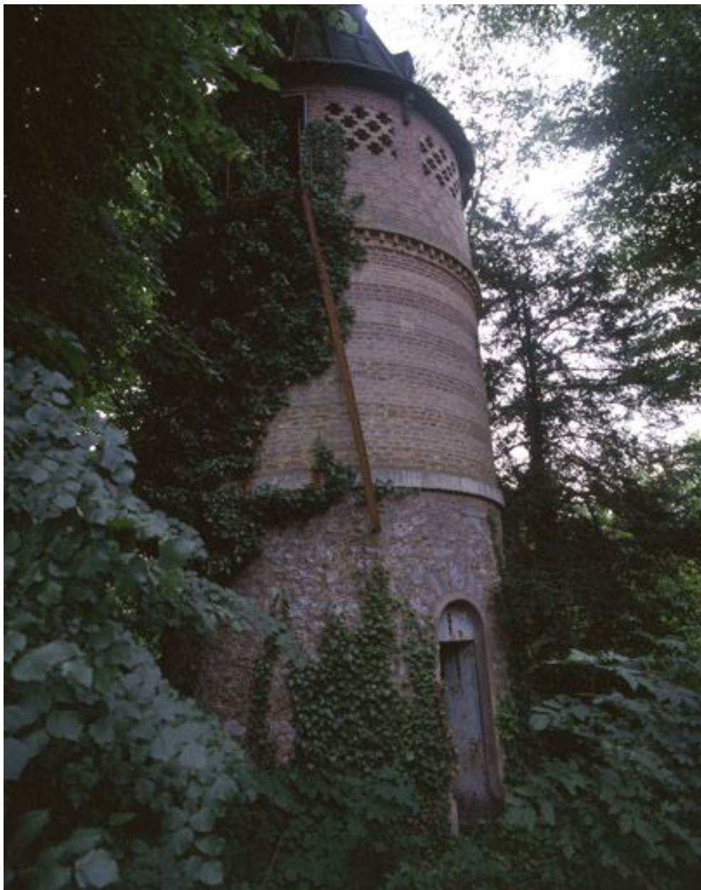
Vue rapprochée du château d'eau.
