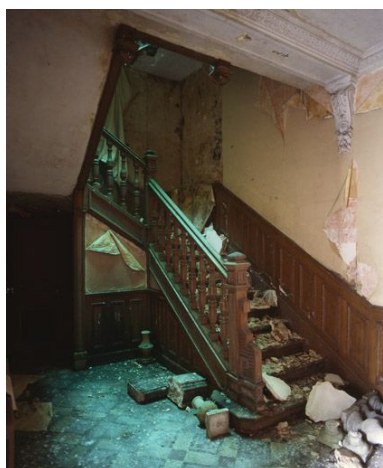
Escalier situé à droite du hall d'entrée. Phot. Philippe Ayrault IVR11_20079100845XA
