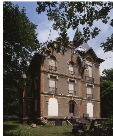
Vue d'ensemble. Phot. Philippe Ayrault IVR11_20079100837XA
