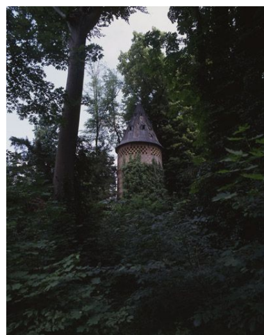
Château d'eau en forme de colombier situé dans le parc. Phot. Philippe Ayrault IVR11_20079100848XA
