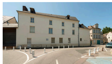
Vue de la façade sur rue du moulin des Cordeliers. Phot. Philippe Ayrault IVR11_20177800887NUC4A
