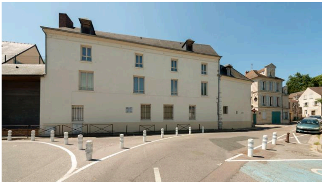
Vue de la façade sur rue du moulin des Cordeliers.
