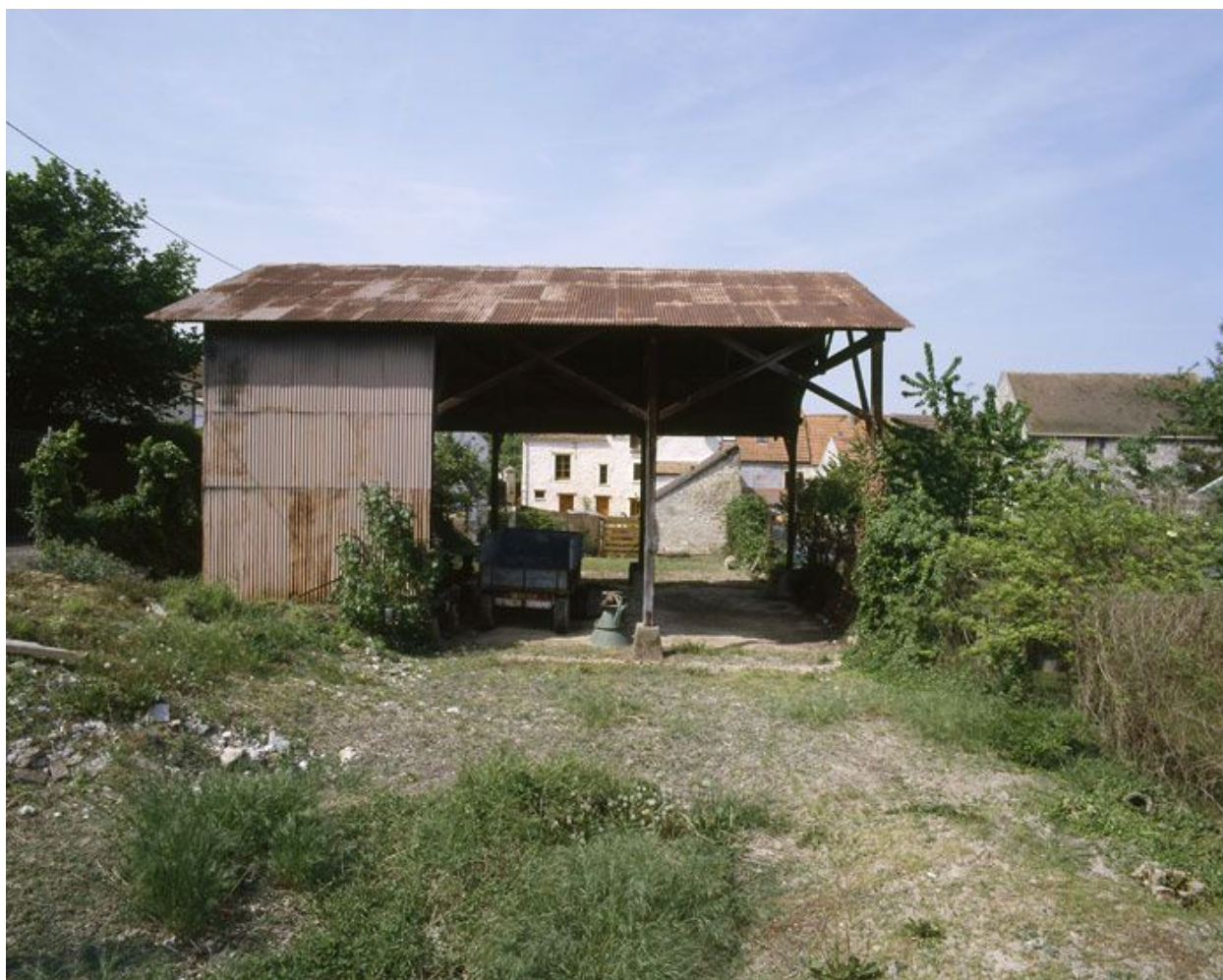
Vue d'un hangar agricole.
