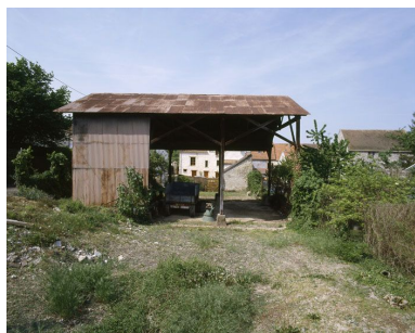
Vue d'un hangar agricole.
