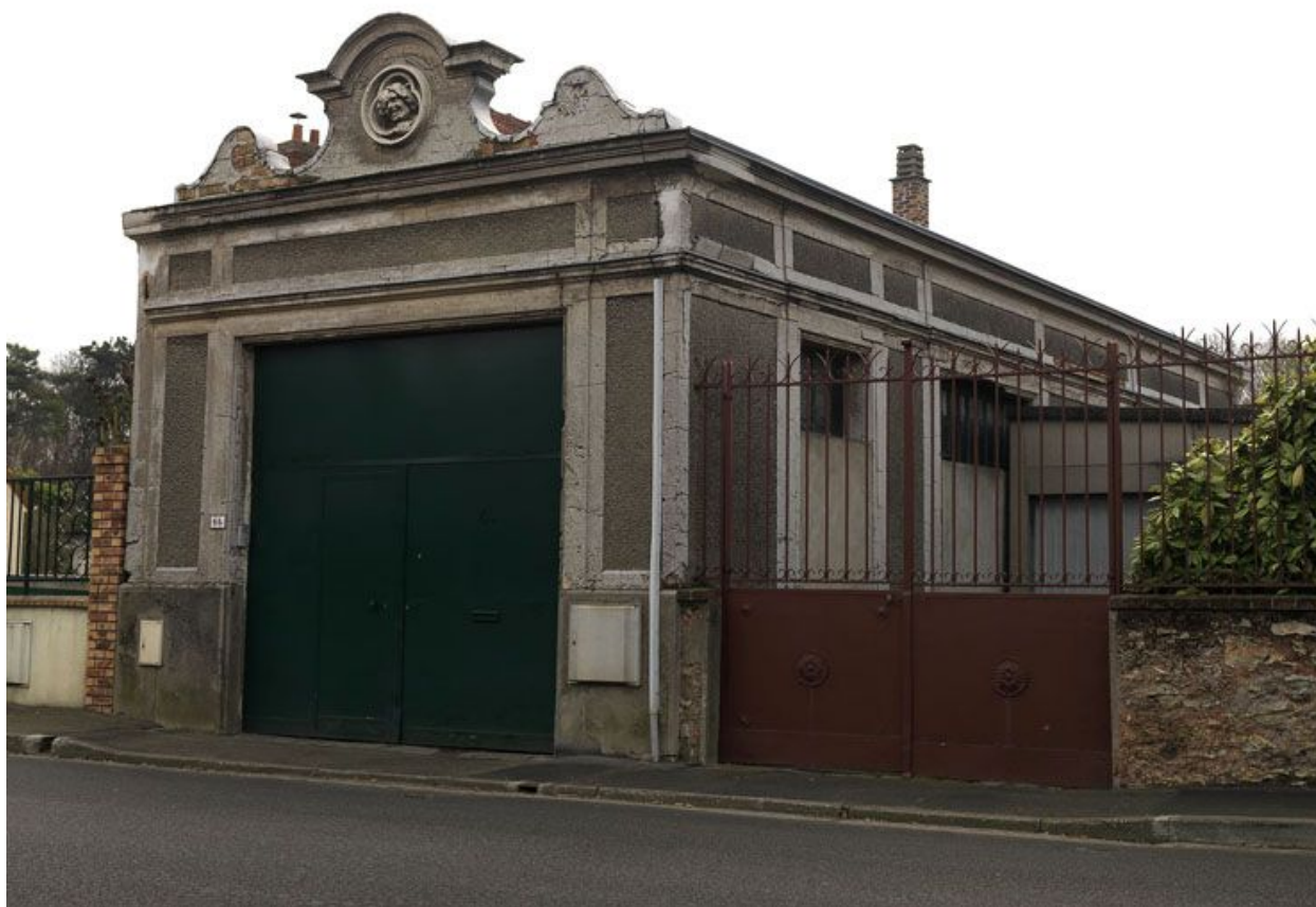
Un ancien atelier, 64 rue Maurice-Berteaux. Vue d'ensemble.
