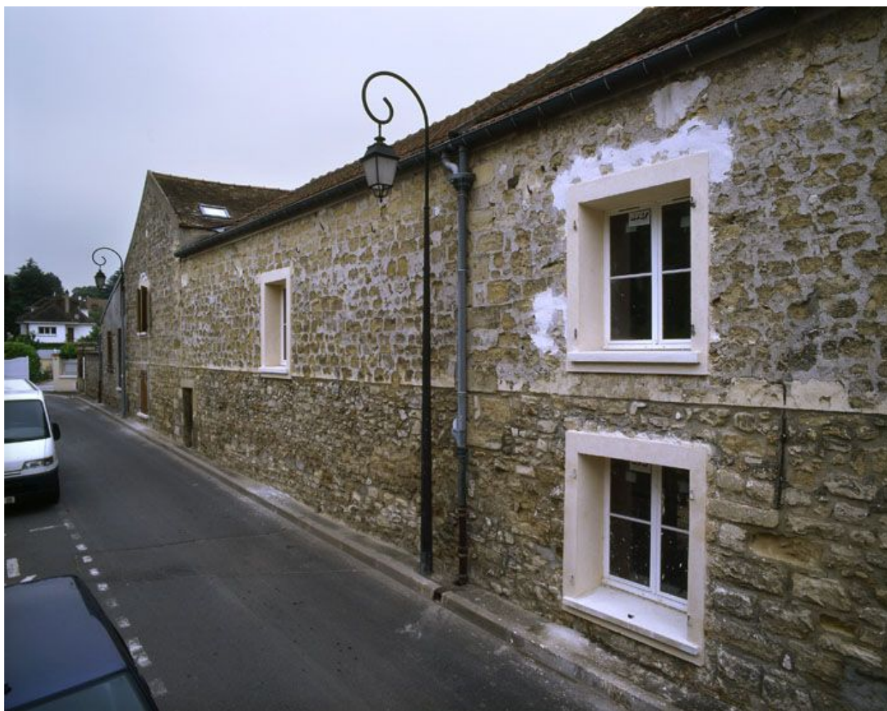
Maison en cours de rénovation, 1 rue de la Gare, la façade latérale donne sur la rue de la Gare.
