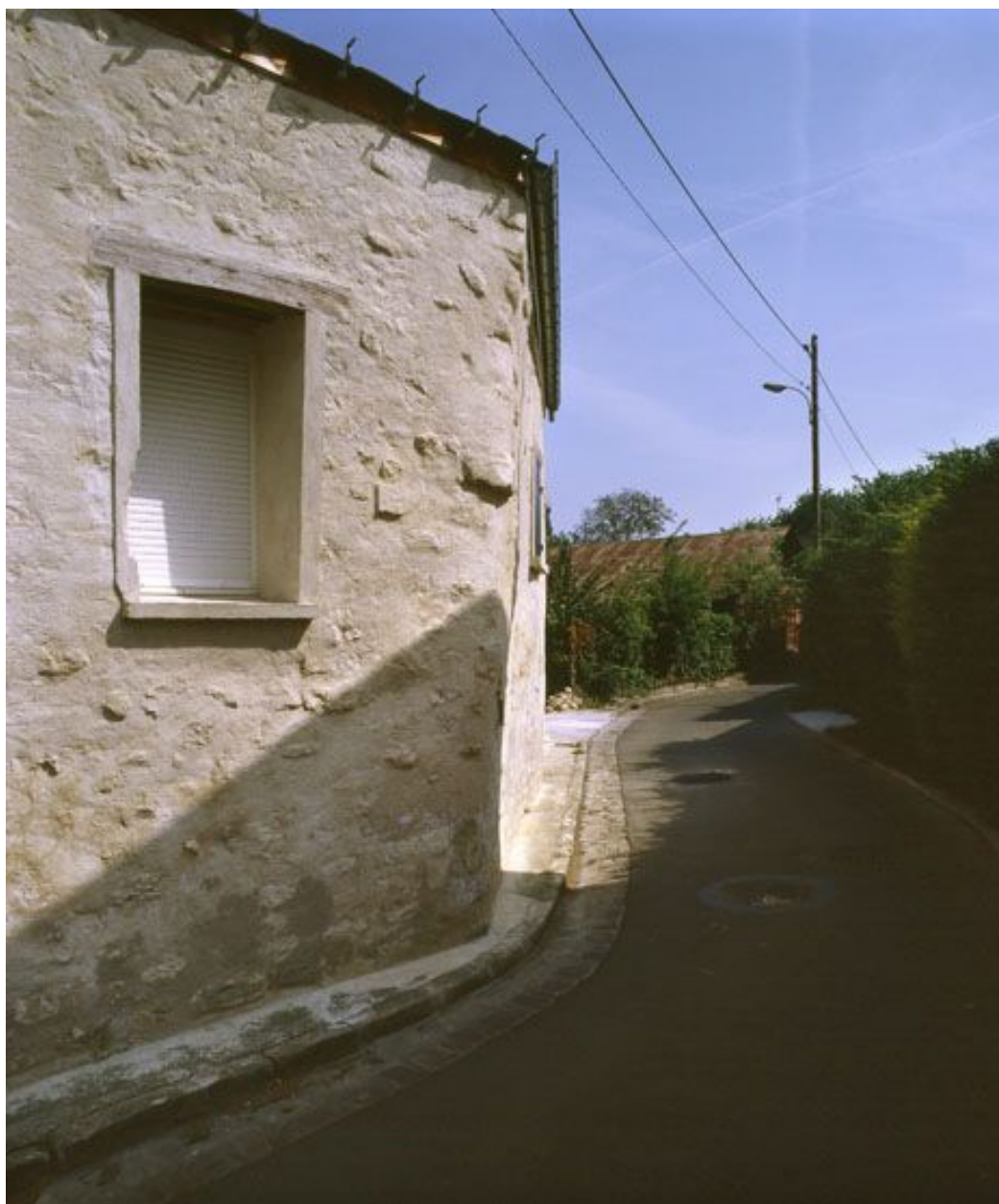
Maurecourt. Mur ancien d'une maison à l'angle de la rue du général de Gaulle et du chemin des Tartaleau.
