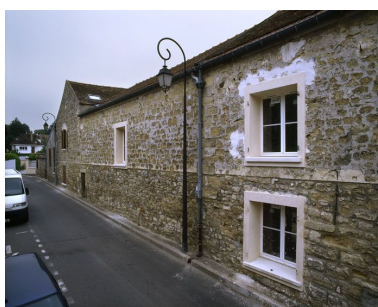
Maison en cours de rénovation, 1 rue de la Gare, la façade latérale donne sur la rue de la Gare. Phot. Laurent Kruszyk IVR11_20077800270XA
