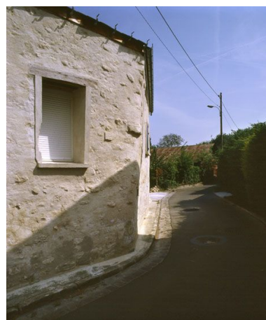
Maurecourt. Mur ancien d'une maison à l'angle de la rue du général de Gaulle et du chemin des Tartaleau. Phot. Laurent Kruszyk IVR11_20077800243XA
