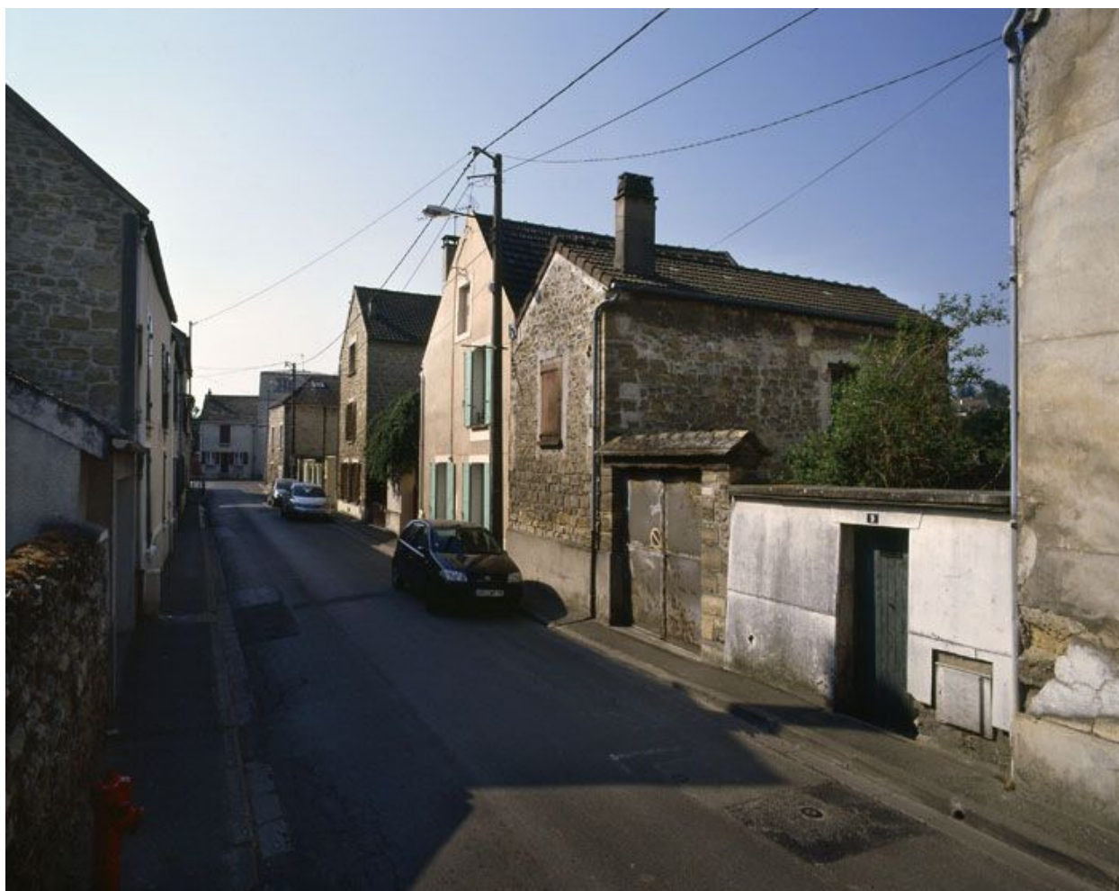
Maurecourt. Alignement de pignons rue de Pontoise.
