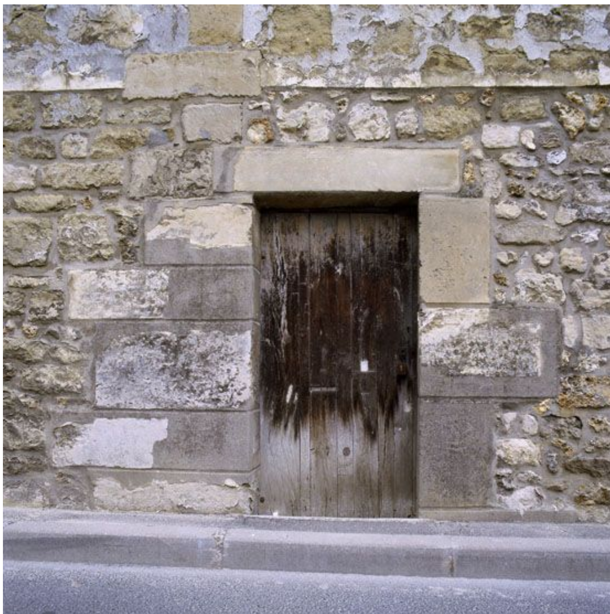
Maison en cours de rénovation, 1 rue de la Gare : une porte latérale.
