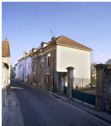
Vue d'une ancienne maison de campagne du XVIIIe siècle découpée en plusieurs parcelles. C'est là que Berthe Morisot venait chez sa soeur. Phot. Laurent Kruszyk IVR11_20077800070XA
