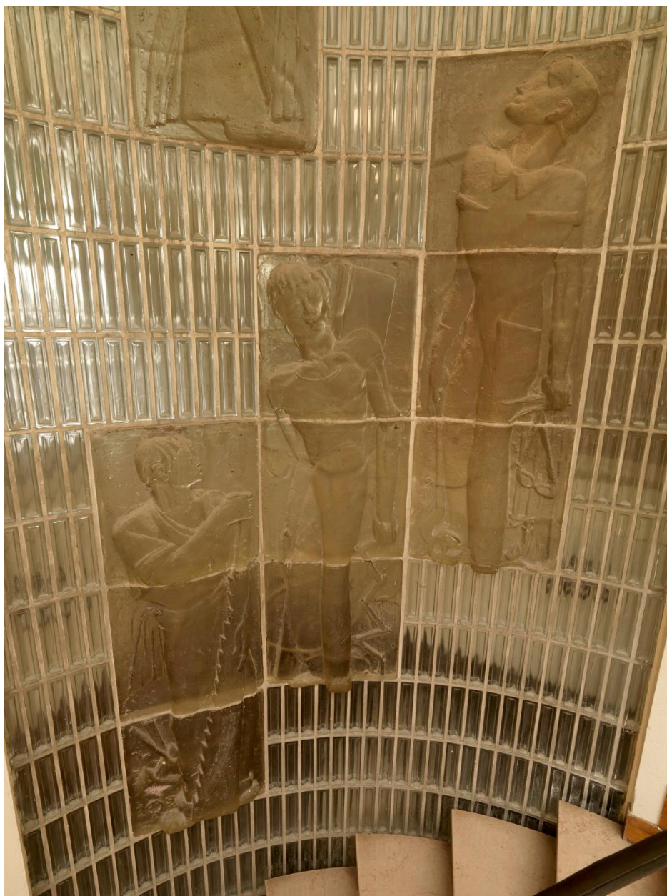
Détail du mur de verre d'Henri Navarre, qui a pour sujet : "En travaillant le fer, le bois et la pierre, l'homme édifie sa maison " (1953).
