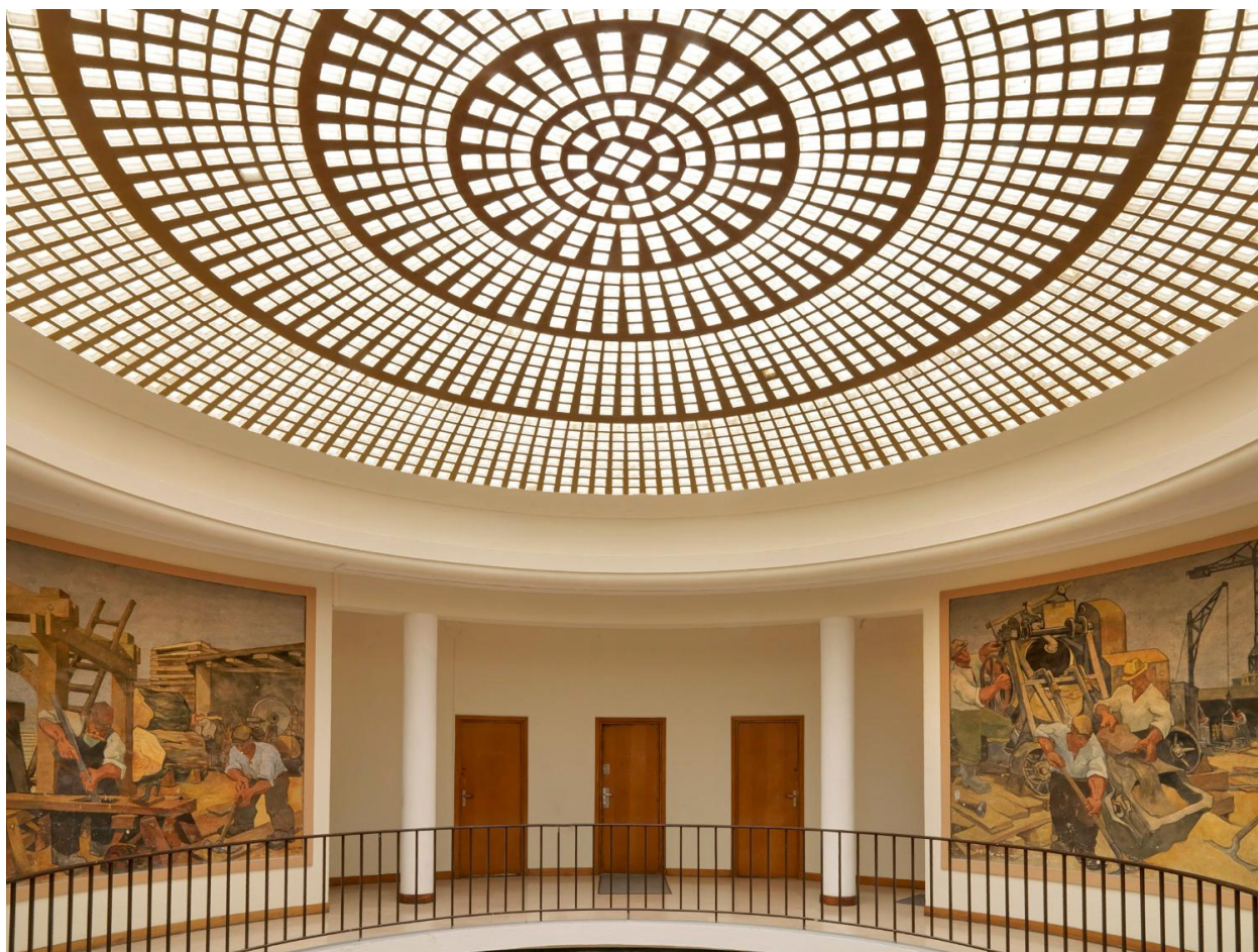
Le hall d'honneur en rotonde de l'établissement, coiffé d'une coupole en pavés de verre.
