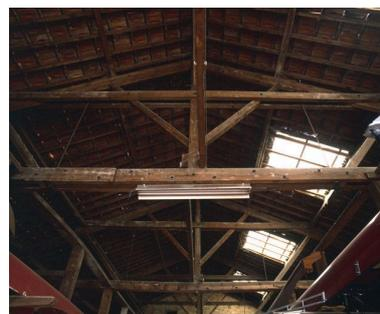
Vue intérieure de la charpente du 2e hangar à bateaux, montrant la structure à entrain et faux-entrait.
