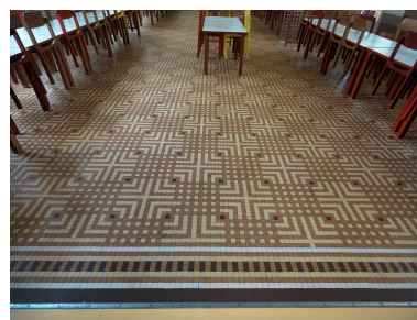
Détail du pavement du réfectoire, qui présente les mêmes motifs géométriques dans une gamme de beiges, ocres et bruns. Phot. Jean-Bernard Vialles IVR11_20169200233NUC4A
