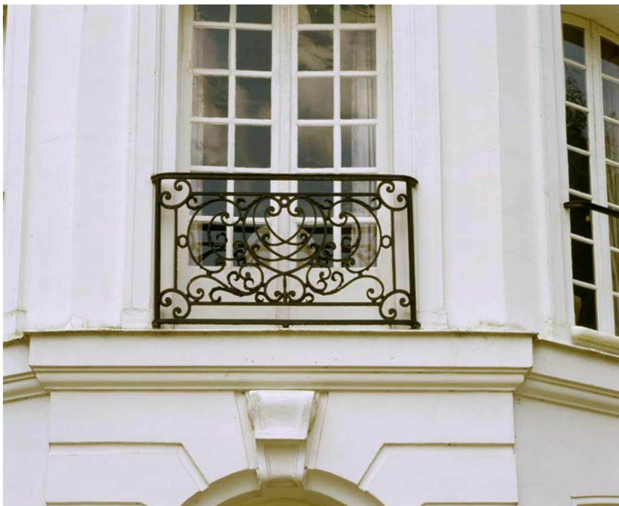
Détail d'un balconnet.
