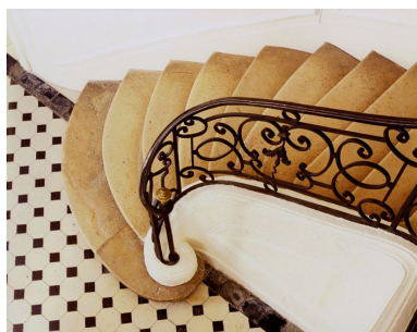
L'escalier vue plongeante sur le départ. Phot. Laurent Kruszyk IVR11_20077800341XA
