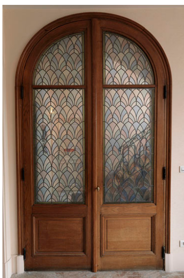
Détail de la porte, à main droite du vestibule d'entrée, située dans la partie agrandie en 1928.
