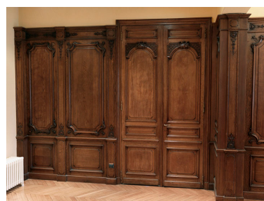
Boiseries actuellement déposées et réinstallées dans un salon, au rez-de-chaussée.
