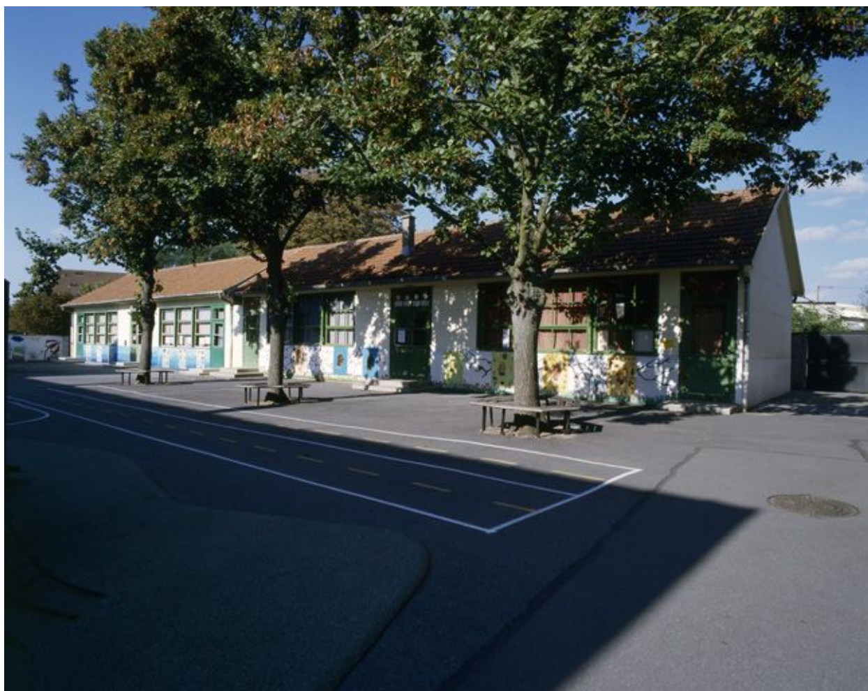
Les salles de classe installées dans les années trente à l'arrière du bâtiment principal.
