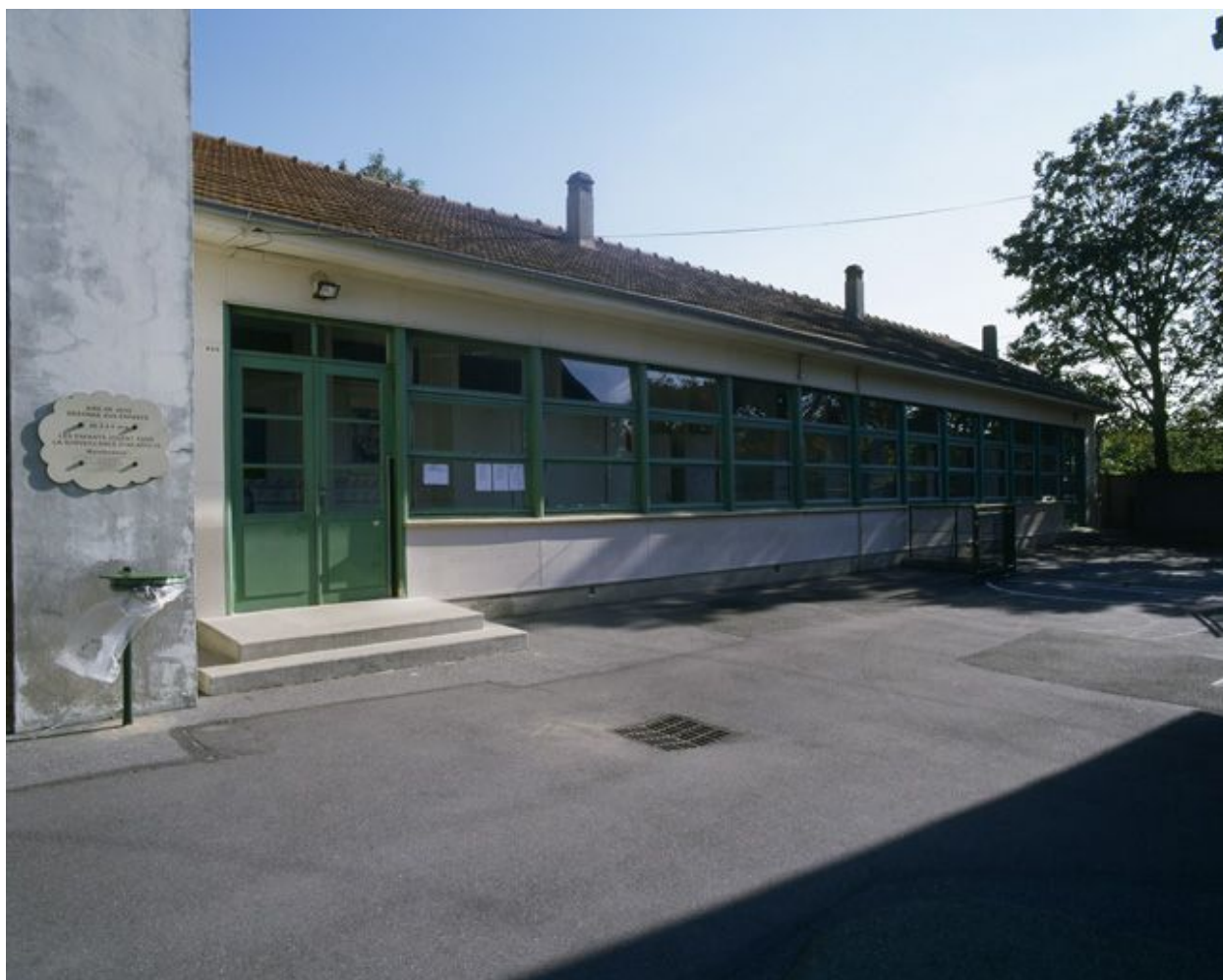
Salles de classe des années 1930 accolées au nouveau bâtiment, le long du côté sud de la cour.
