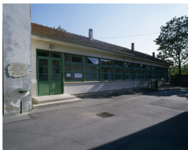
Salles de classe des années 1930 accolées au nouveau bâtiment, le long du côté sud de la cour. Phot. Philippe Ayrault IVR11_20069101138XA
