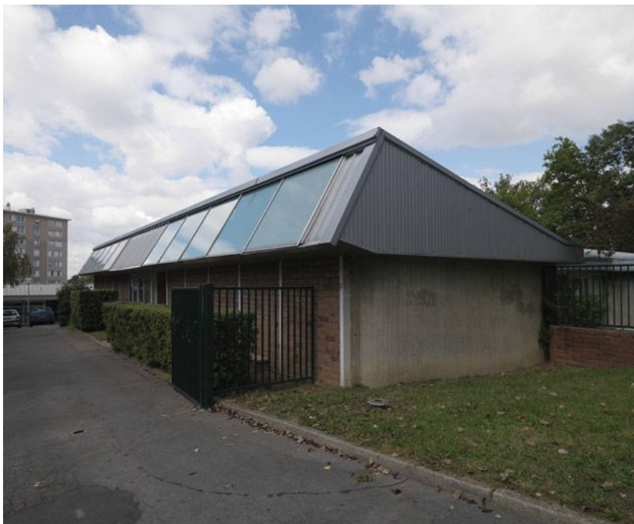
Groupe scolaire Louise-Michel : salles de classe en rez-de-chaussée près de l'entrée.
