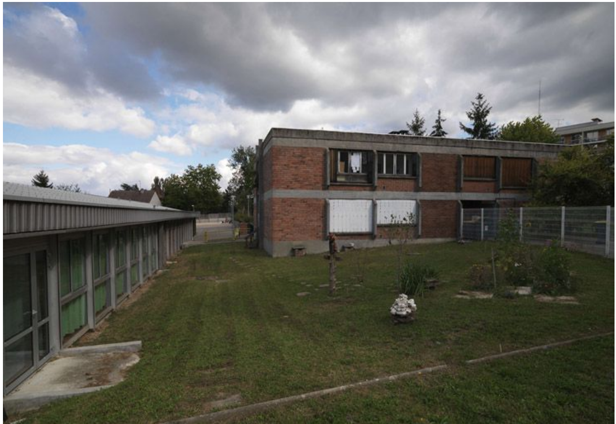
Groupe scolaire Louise-Michel : logements des instituteurs.
