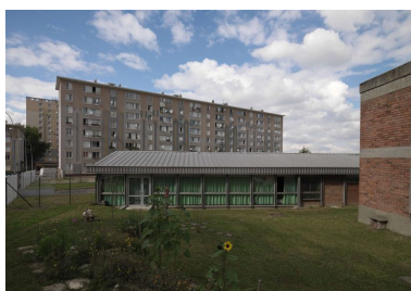
Groupe scolaire Louise-Michel : un des bâtiments scolaires à côté du logement des instituteurs. Phot. Philippe Ayrault IVR11_20089100034NUC4A
