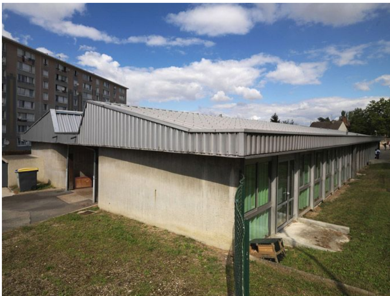
Groupe scolaire Louise-Michel : vue d'ensemble d'un bâtiment de salles de classe.
