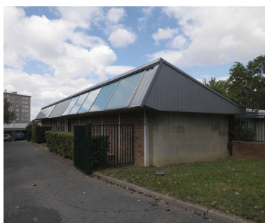
Groupe scolaire Louise-Michel : salles de classe en rez-de-chaussée près de l'entrée. Phot. Philippe Ayrault IVR11_20089100037NUC4A
