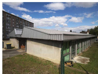
Groupe scolaire Louise- Michel : vue d'ensemble d'un bâtiment de salles de classe. Phot. Philippe Ayrault IVR11_20089100039NUC4A
