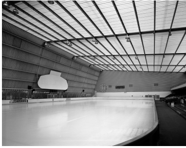
Vue intérieure de la patinoire. Phot. Christian Décamps IVR11_19879200320VS
