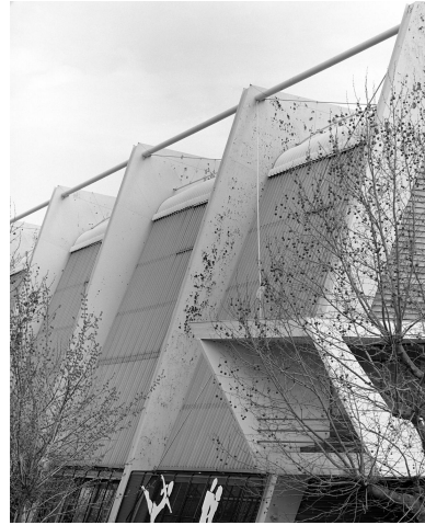
Vue de la façade ouest de la patinoire. Phot. Christian Décamps IVR11_19879200324XS
