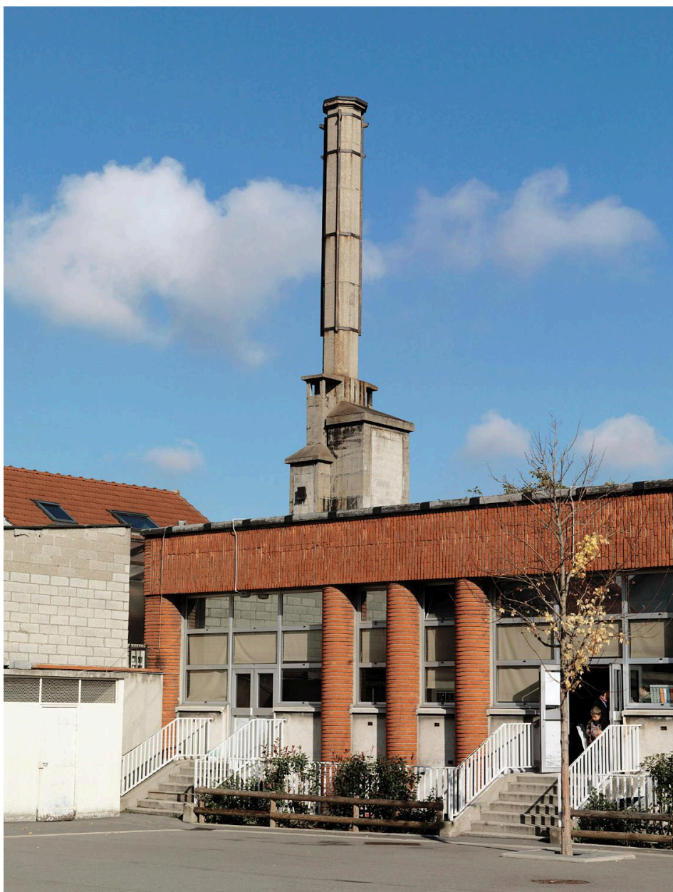
Vue de la cheminée de la chaudière.
