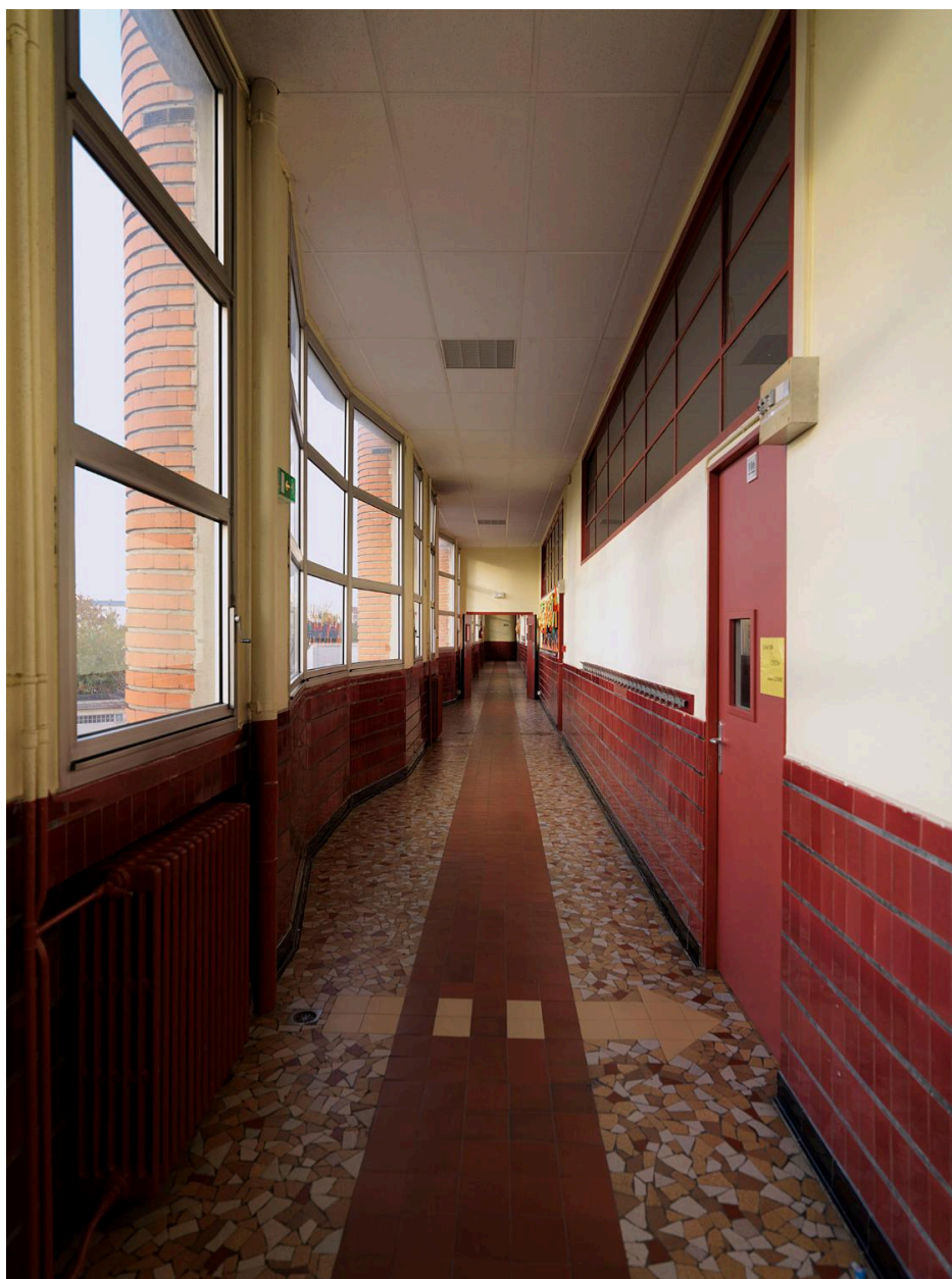
Couloir desservant les classes, école des garçons.
