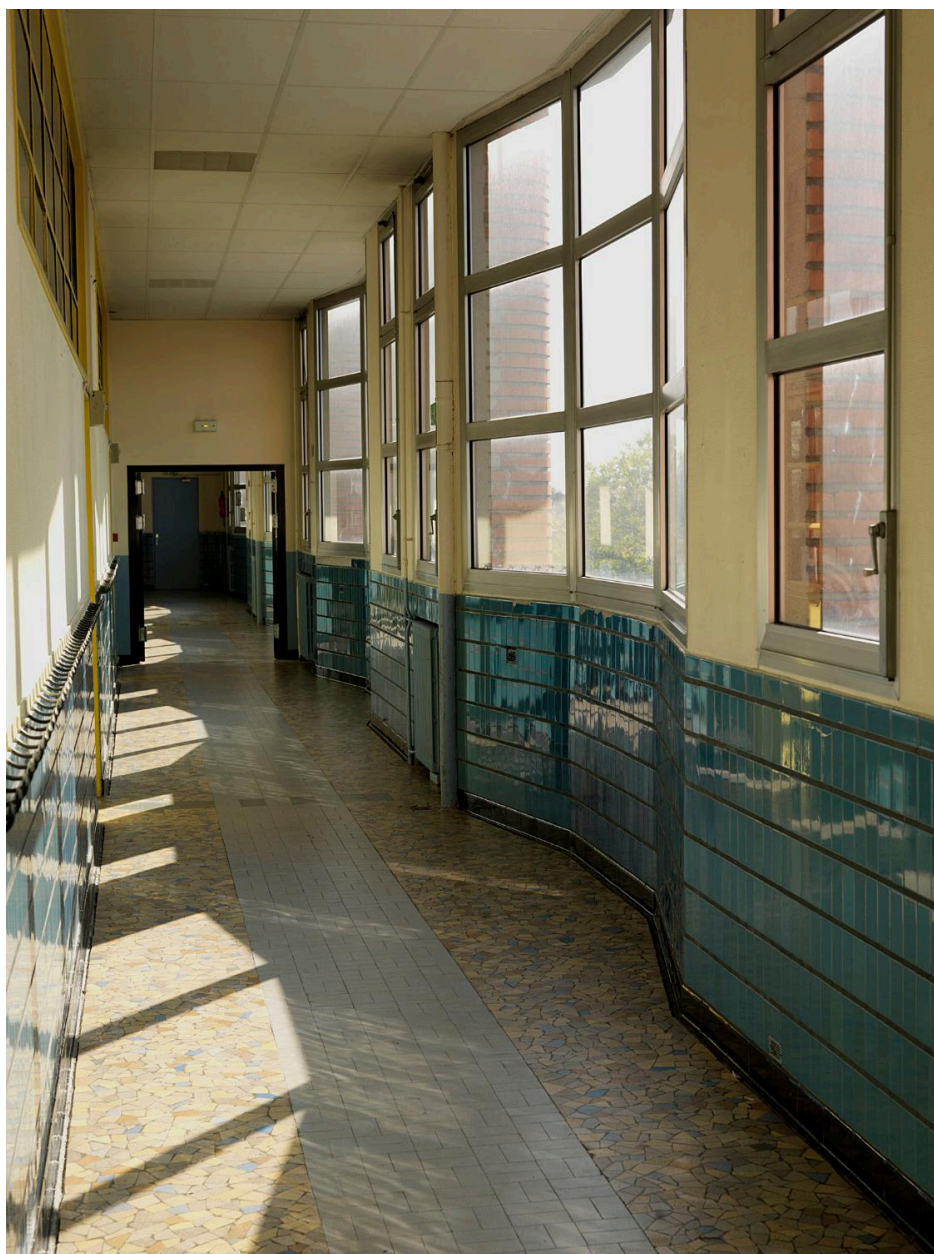
Couloir desservant les classes, école des filles.
