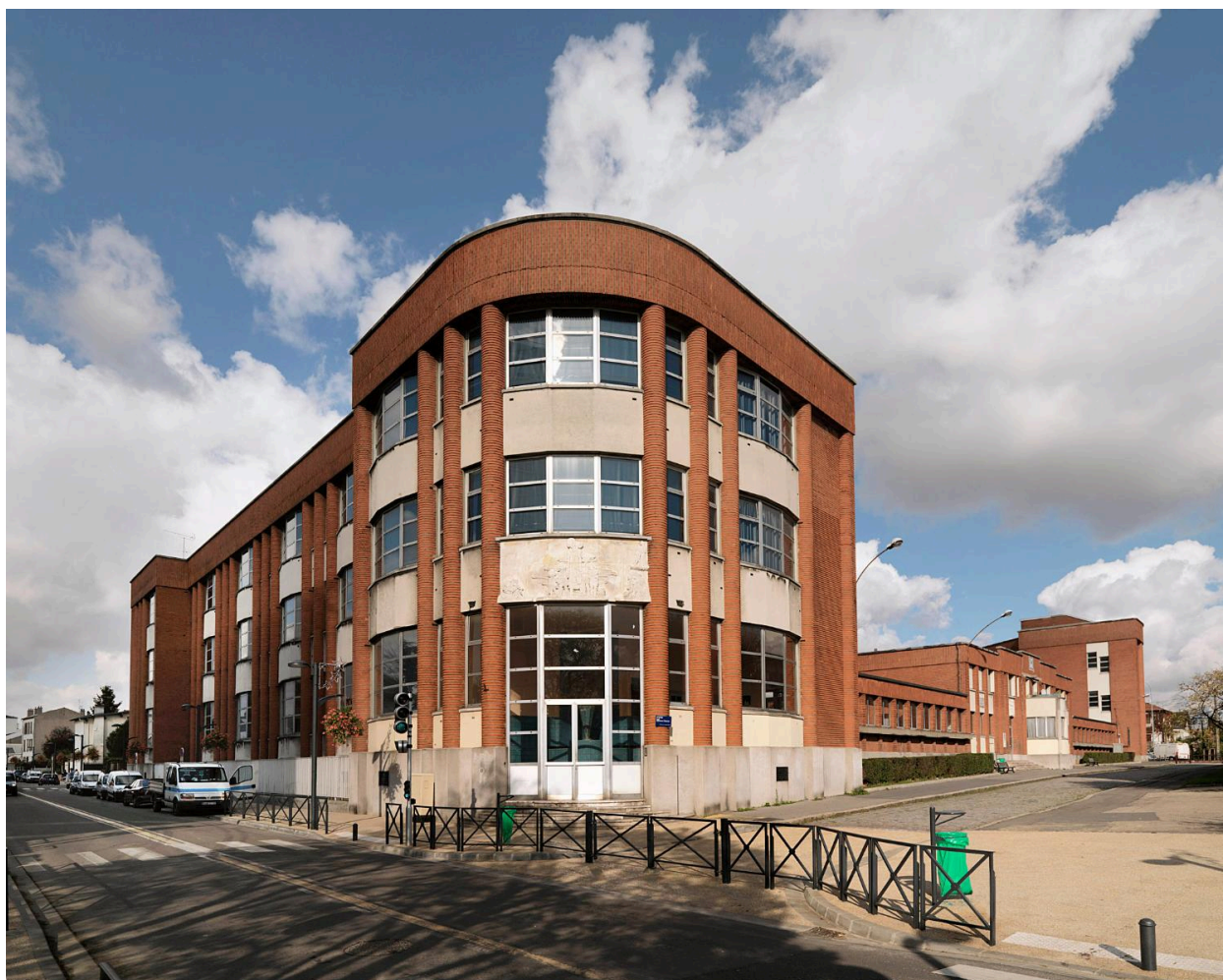
Vue générale du groupe scolaire, construit en 1939.
