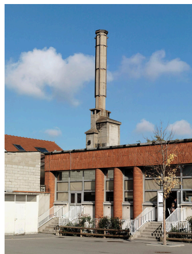
Vue de la cheminée de la chaudière. Phot. Jean-Bernard Vialles IVR11_20089300284NUC4A
