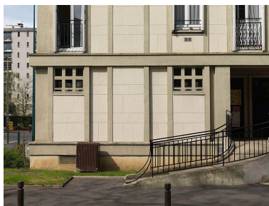
Façade avec une partie de la rampe d'accès. Les fenêtres du rez-de-chaussée ont été remplacées par de petites ouvertures avec un quadrillage de sécurité en béton. Phot. Stéphane Asseline IVR11_20119100190NUC4A
