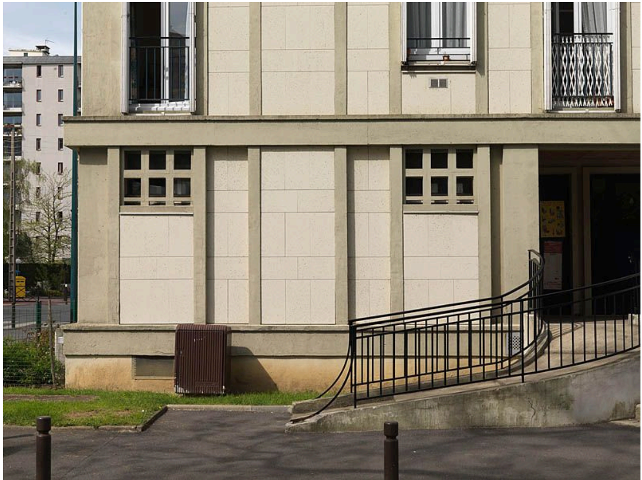
Façade avec une partie de la rampe d'accès. Les fenêtres du rez-de-chaussée ont été remplacées par de petites ouvertures avec un quadrillage de sécurité en béton.
