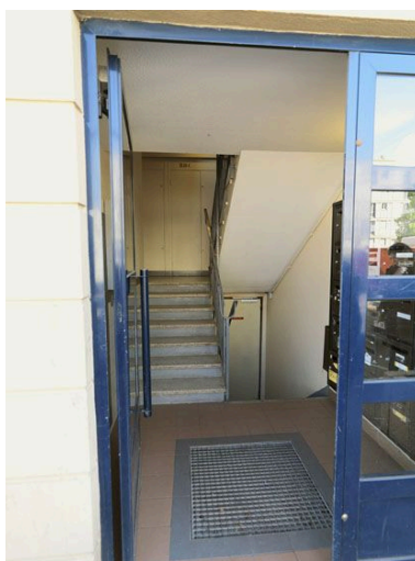
Entrée de la barre C. Phot. Jean-Bernard Vialles IVR11_20109100038NUC4A
