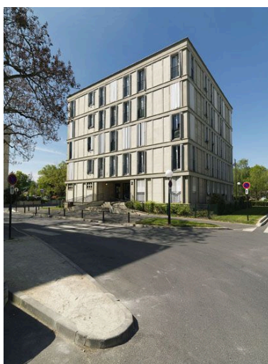
Le plot A avec la double rampe d'accès. Phot. Jean-Bernard Vialles IVR11_20109100039NUC4A
