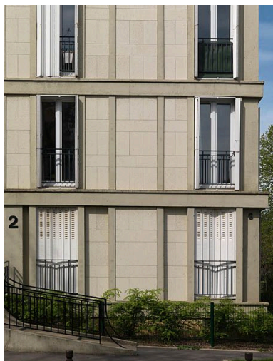
Façade rythmée verticalement grâce aux travées de fenêtres étroites et hautes. Phot. Stéphane Asseline IVR11_20119100189NUC4A
