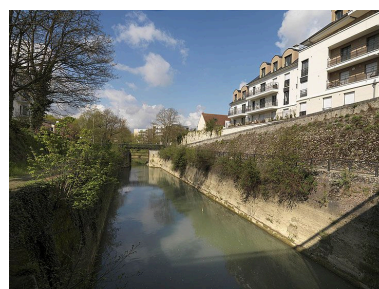
L'écluse, vue de l'est. Phot. Jean-Bernard Vialles IVR11_20127700288NUC4A
