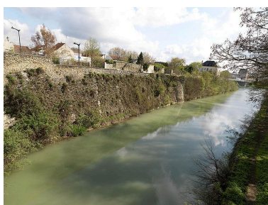
La partie orientale du canal. Phot. Jean-Bernard Vialles IVR11_20127700287NUC4A
