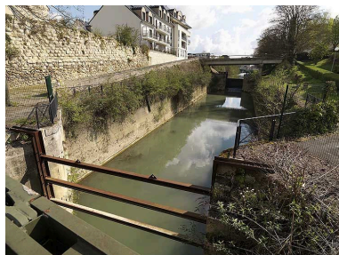
L'écluse, vue de l'ouest. Phot. Jean-Bernard Vialles IVR11_20127700289NUC4A
