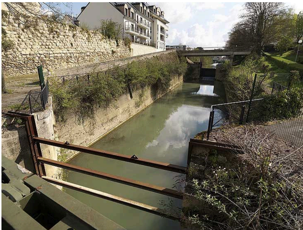
L'écluse, vue de l'ouest.
