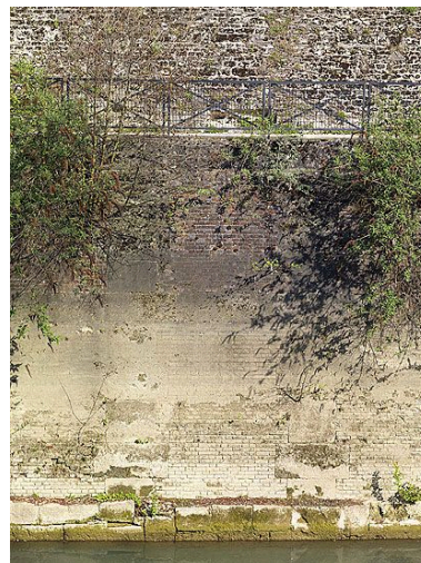
Détail de la mise en oeuvre du mur au niveau de l'écluse, en brique avec chaînages de pierre. Phot. Jean-Bernard Vialles IVR11_20127700290NUC4A
