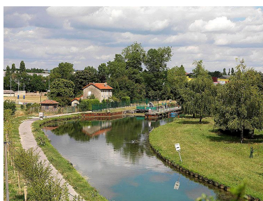
Le canal et l'écluse Saint-Lazare. Phot. Jean-Bernard Vialles IVR11_20137700399NUC4A
