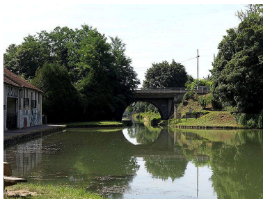
Le port à la limite des communes de Meaux et de Villenoy, vu depuis Meaux. Dans le fond, le pont de la chaussée de Paris. Phot. Jean-Bernard Vialles IVR11_20137700240NUC4A
