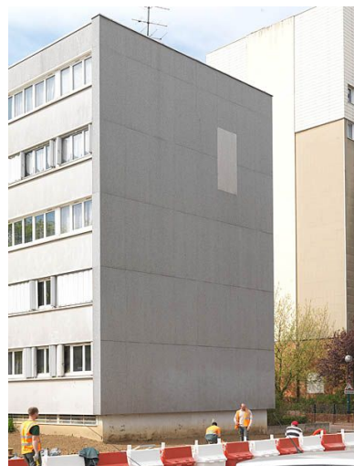
Le pignon d'une barre R+4. Contrairement aux façades composées de fenêtres en bande, le pignon est constitué de panneaux pleins avec un jeu sur la couleur d'un des panneaux que l'on retrouve sur plusieurs bâtiments de l'ensemble. Phot. Stéphane Asseline IVR11_20119100174NUC4A
