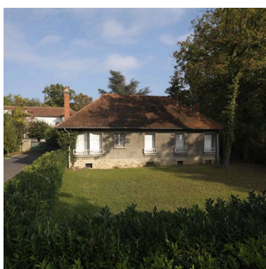
Vue d'un pavillon d'habitation, situé à côté du pavillon double affecté au logement de la direction (à l'extrême sud du quadrilatère). Phot. Philippe Ayrault IVR11_20089100126NUC4A
