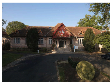
Vue du bâtiment d'entrée. Phot. Philippe Ayrault IVR11_20089100102NUC4A
