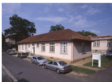
Vue du bâtiment en rez-de-chaussée situé à l'arrière du pavillon central (J.-S.-Bach), en direction de la division Jacques-Grancher.
