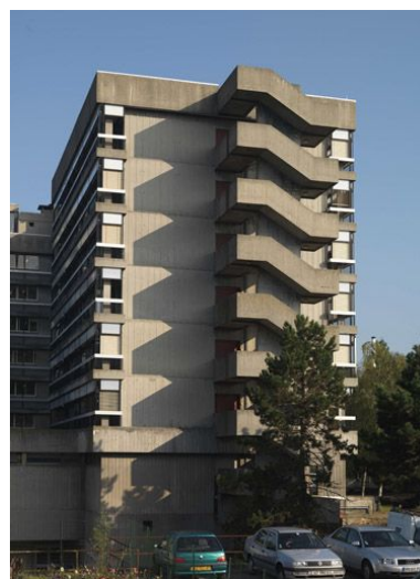
Vue latérale du nouveau bâtiment Georges-Brassens. Phot. Philippe Ayrault IVR11_20089100104NUC4A
