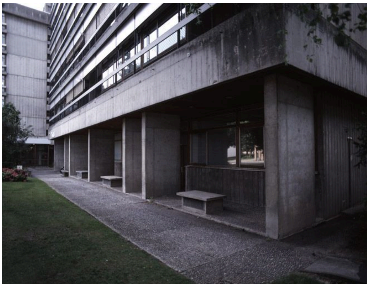
Bâtiment Georges-Brassens : détail du rez-de-chaussée.
