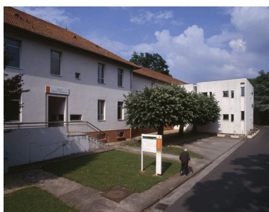
La division Laennec rénovée dans les années 1975. Phot. Philippe Ayrault IVR11_20079100890XA
