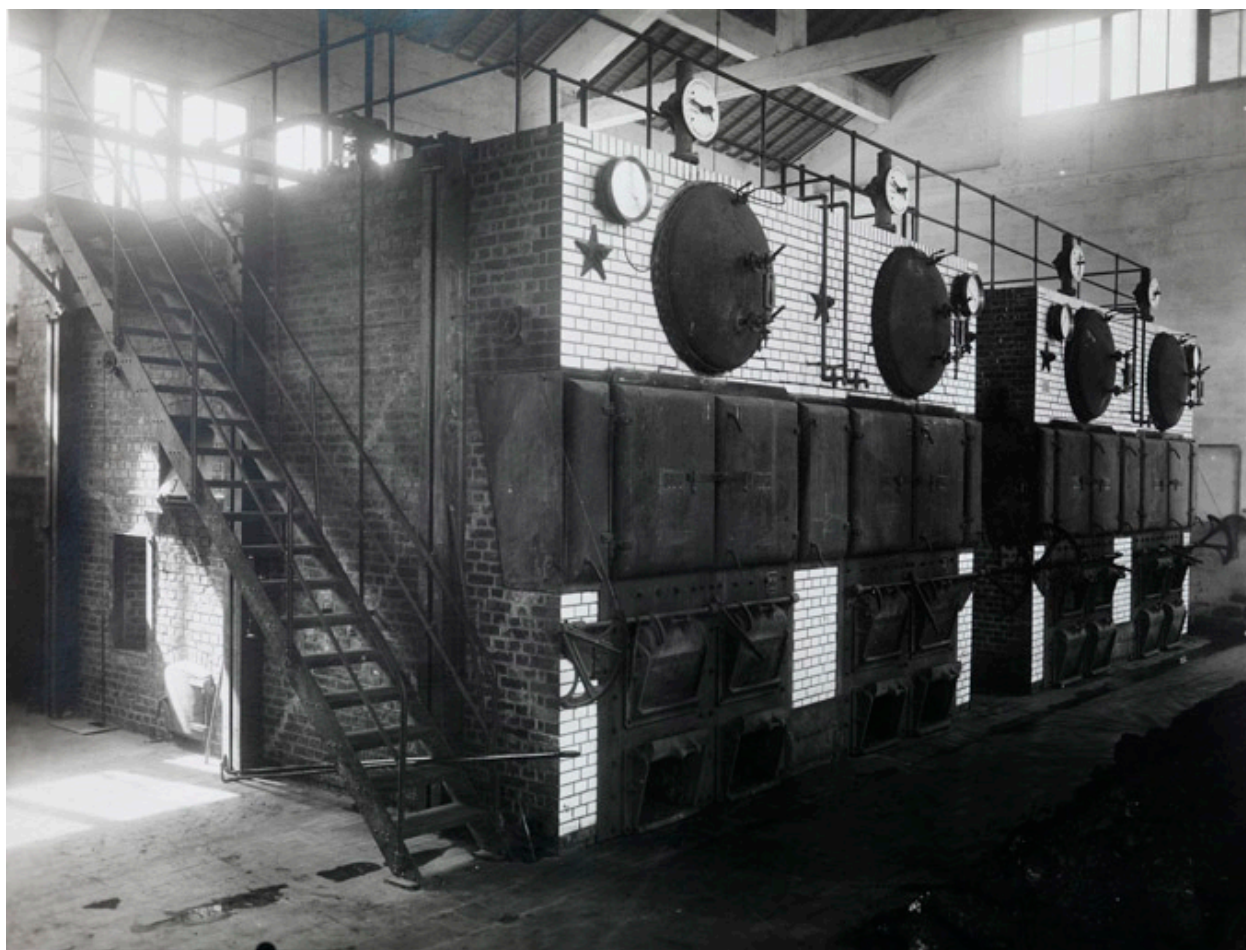
Les chaudières. (Archives de l'Assistance publique, 3 Fi 3/20)
