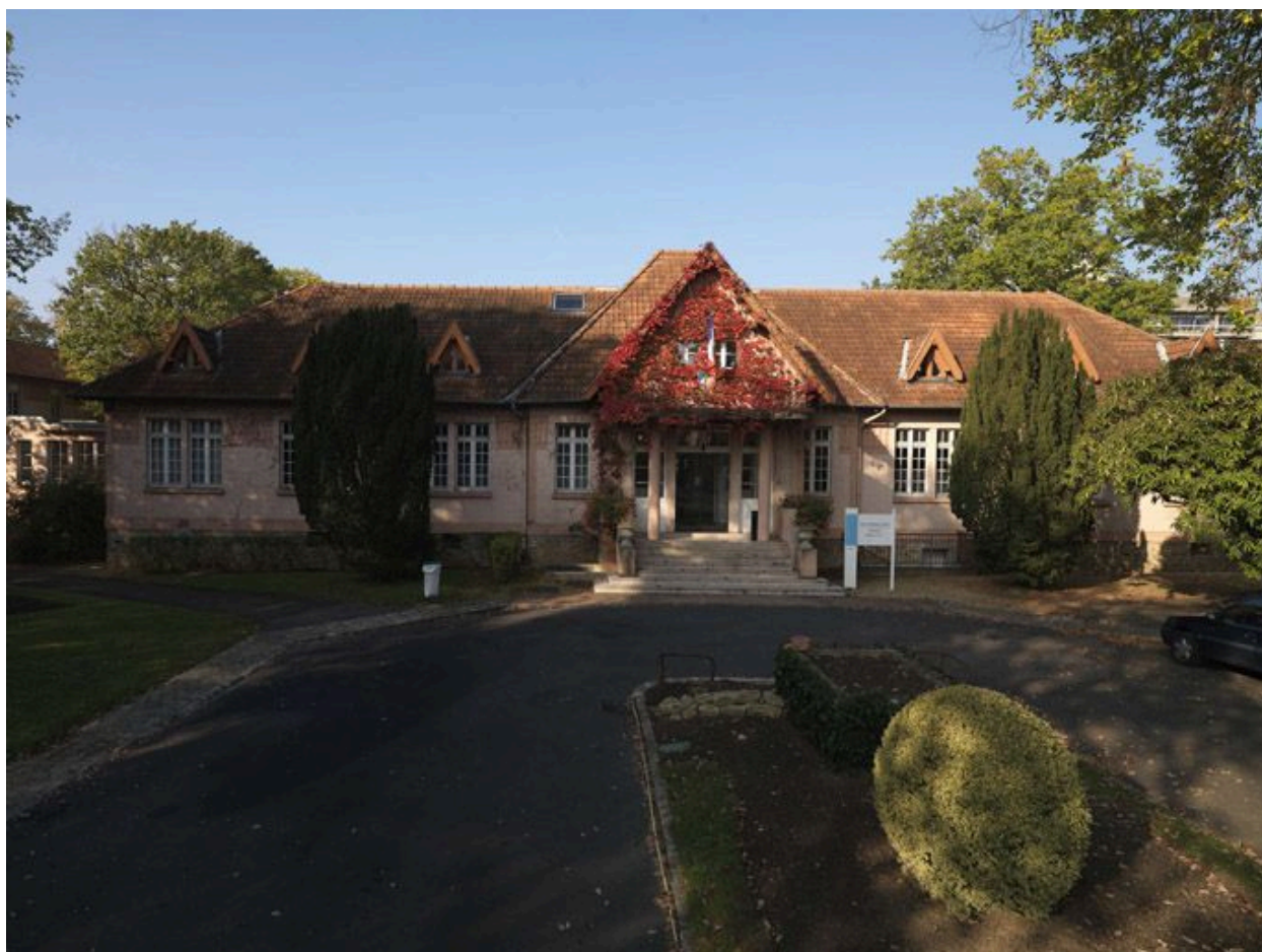
Vue du bâtiment d'entrée.
