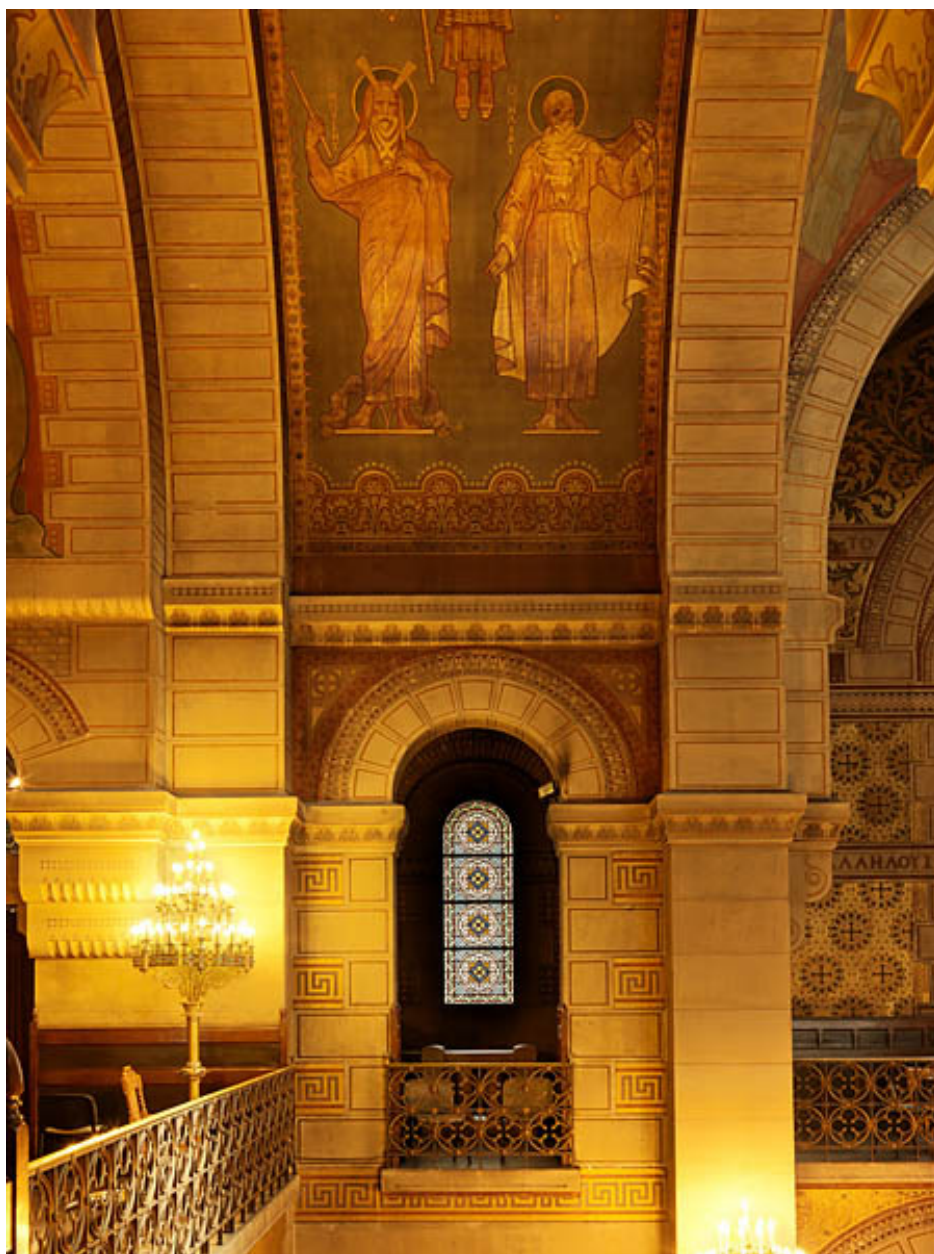
Verrière haute ornementale (baies 101, 102, 105 ou 106), par Louis Avenet, vers 1895. Avenet, Louis (peintre-verrier)
