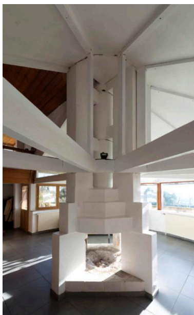
Vue générale de la cheminée centrale (intérieure). Phot. Philippe Ayrault IVR11_20166100014NUC4A
