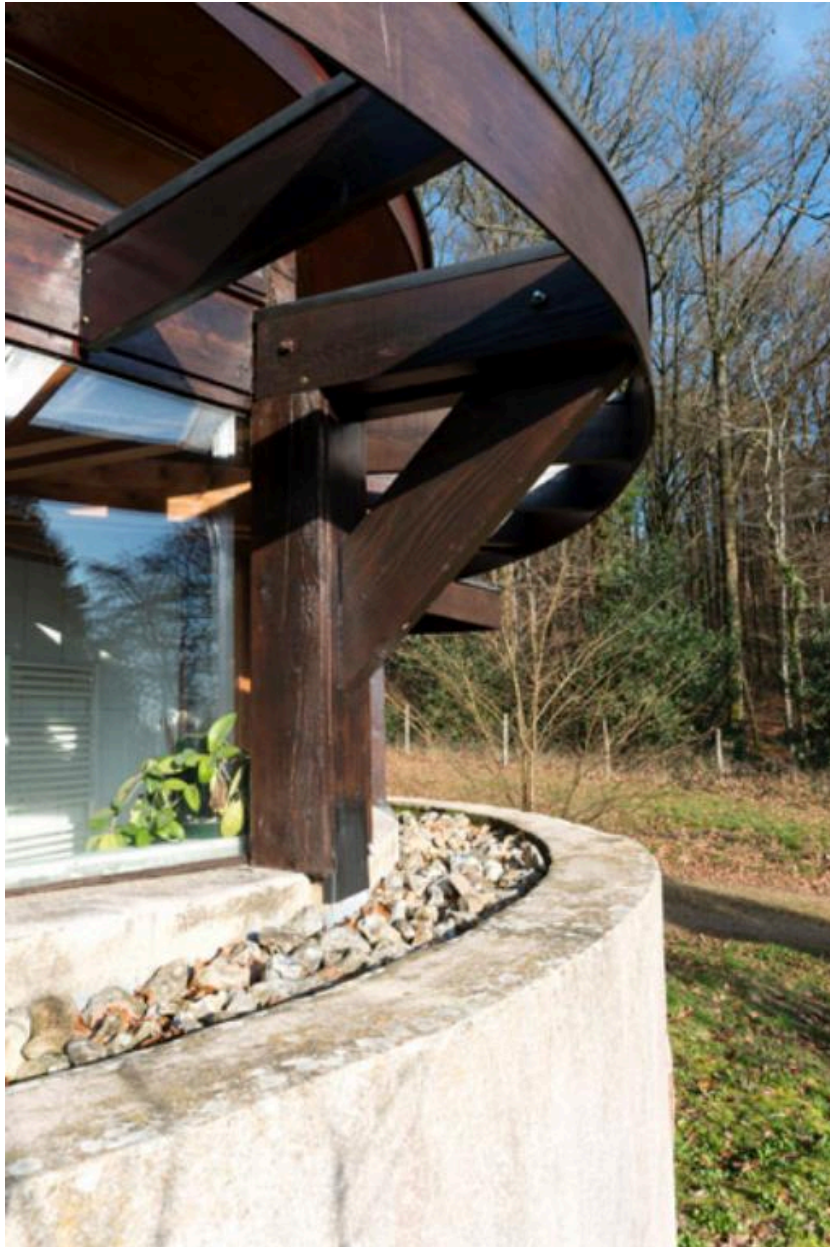
Détail d'une fenêtre (côté droit).
