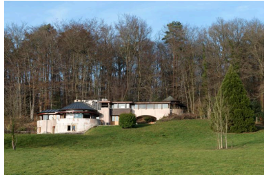
Vue générale de la maison. Phot. Philippe Ayrault IVR11_20166100001NUC4A
