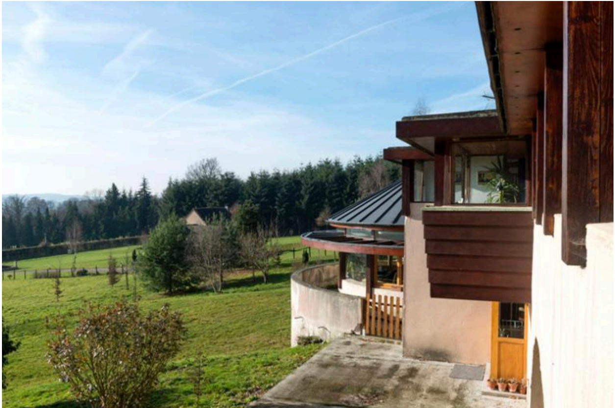
Vue latérale de la façade.
