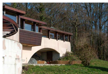
Vue de l'arche de soutènement. Phot. Philippe Ayrault IVR11_20166100012NUC4A
