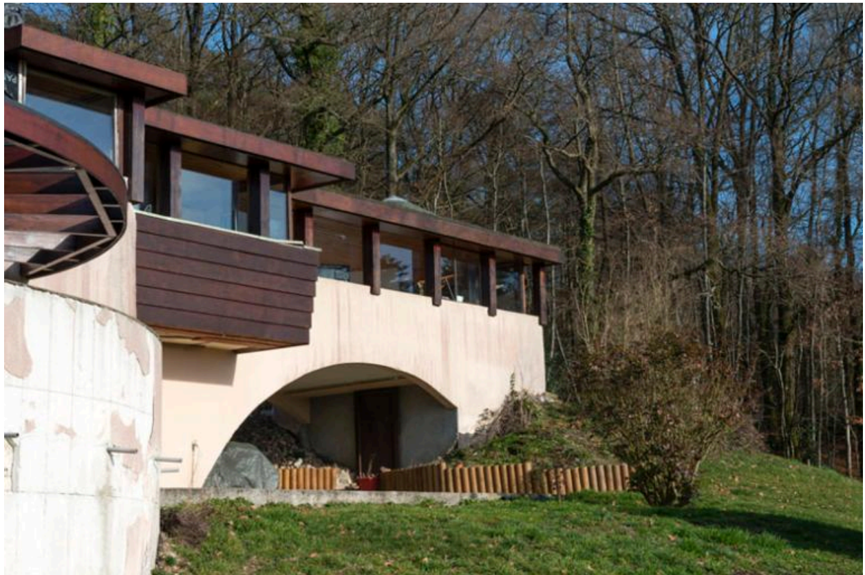
Vue de l'arche de soutènement.
