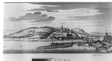
Vue de Meulan vers l'amont depuis les rives de l'île Belle. Sur la droite, on peut voir les bastions de l'île au Fort et le pont routier sur la Seine n°1 dit Petit Pont. Gravure, 17e siècle. IVR11_20117800429NUC2
