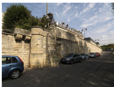
Vestiges de la naissance du pont. On aperçoit le début d'une arche et deux encorbellements identiques à ceux du Petit Pont. Phot. Laurent Kruszyk IVR11_20117800258NUC4A
