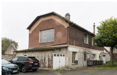
Vue générale Phot. Laurent Kruszyk IVR11_20199100453NUC4A
