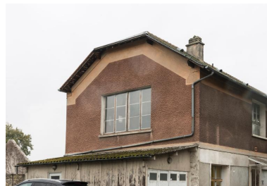
Vue générale Phot. Laurent Kruszyk IVR11_20199100454NUC4A
