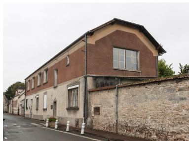
Vue générale Phot. Laurent Kruszyk IVR11_20199100452NUC4A
