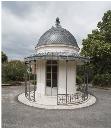
Vue d'ensemble de la lanterne surmontée d'un dôme couvert d'ardoises. Une pomme de pin posée sur un socle flanqué de quatre consoles rampantes constitue l'amortissement du faîtage. Des colonnes de fer à chapiteaux corinthiens supportent l'appentis.
