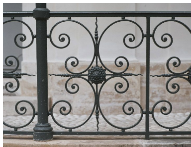
Détail d'un panneau de la rambarde métallique sur le pourtour de la Lanterne.
