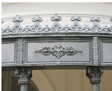
Détail du bandeau circulaire. Il est panneauté par des baguettes de zinc moulurées et chaque panneau est orné en son centre par un motif de rinceaux réalisé en zinc repoussé et soudé.
