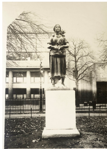
Vue prise de face et devant la mairie annexe. IVR11_20157500488NUC4A
