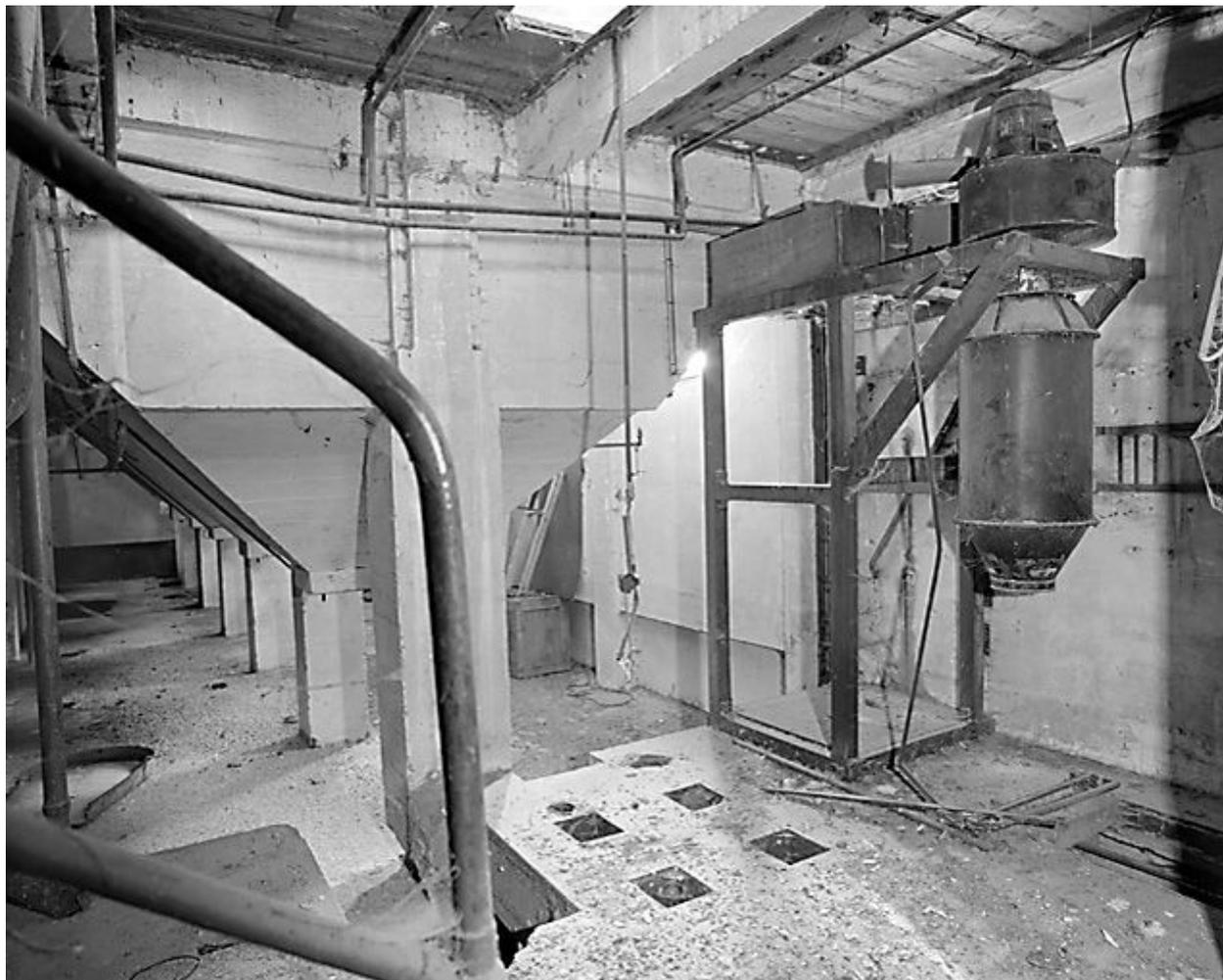
Silos à grains. Trémies en béton armé.
