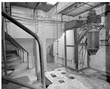
Silos à grains. Trémies en béton armé.
