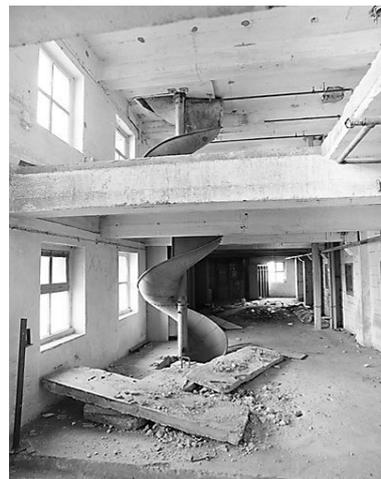
Partie magasin à farine. Au 2e étage, le toboggan hélicoïdal de manutention, utilisé pour l'acheminement de sacs de farine jusqu'au quai de chargement.
