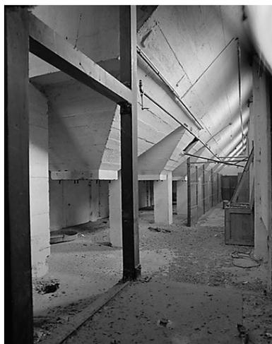
Silos à grains. Trémies en béton armé.
