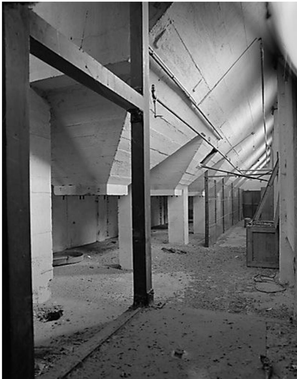
Silos à grains. Trémies en béton armé.
