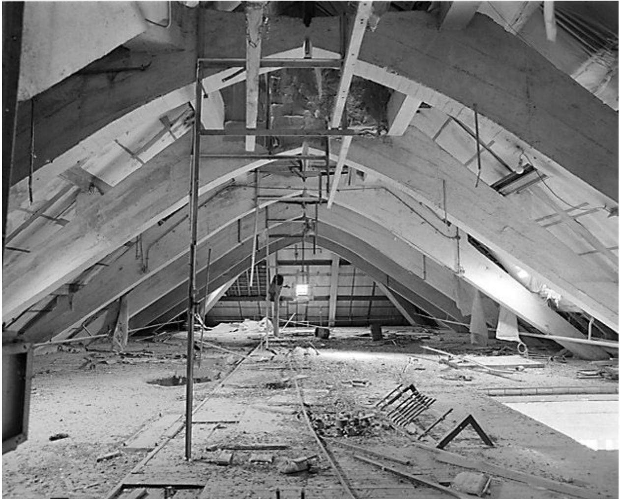
Vue des combles. Sous la charpente en béton étaient placés les cyclones et l'installation pneumatique, principale innovation de la minoterie.
