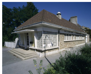
Vue d'ensemble. Phot. Philippe Ayrault IVR11_20069101142XA
