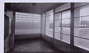
Deux vues du hall d'entrée des bains-douches. (AD Essonne) Autr. Louis Rémy Sabattier IVR11_20059101674XAB
